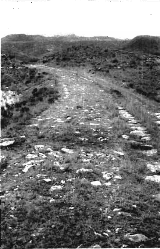
Foto 24.—Vista de la calzada en dirección a Arzo.
