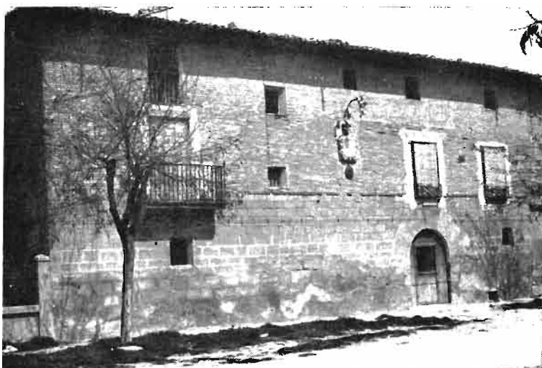
Foto 1.—Casa Loyola. Obsérvese el empleo de piedra y ladrillo en una misma construcción y la disimetría de los vanos.
