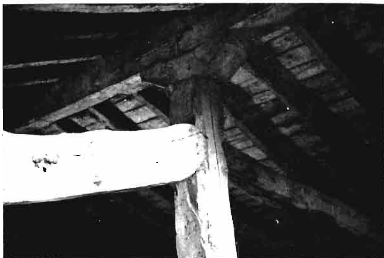
Foto 1.—Detalle del tejado en el último piso de casa Rebolé.
