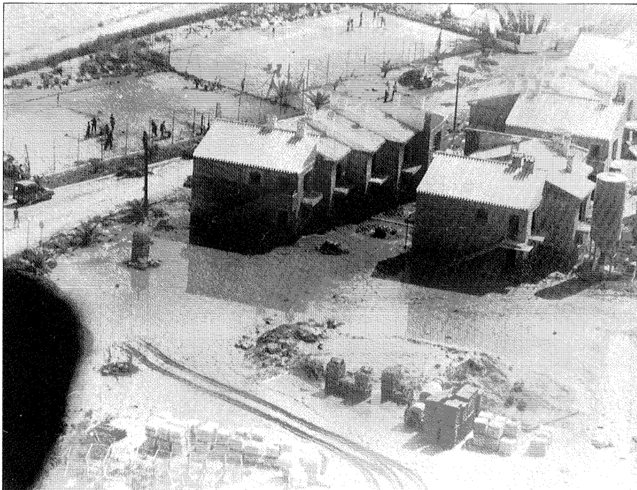
FOTOGRAFÍA 9. Lamentable aspecto de la urbanización Pueblo Laguna, en la desembocadura del río Antas, tras las tormentas del 7-septiembre-1989
