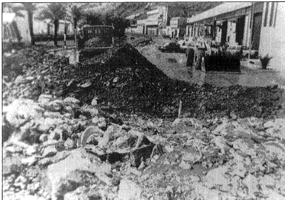
FOTOGRAFÍA 10. Ayalancha de materiales detérricos sobre la CN-340, tramo Almería-Aguadulce (7-septiembre-1989). Sector portuario de Almería
