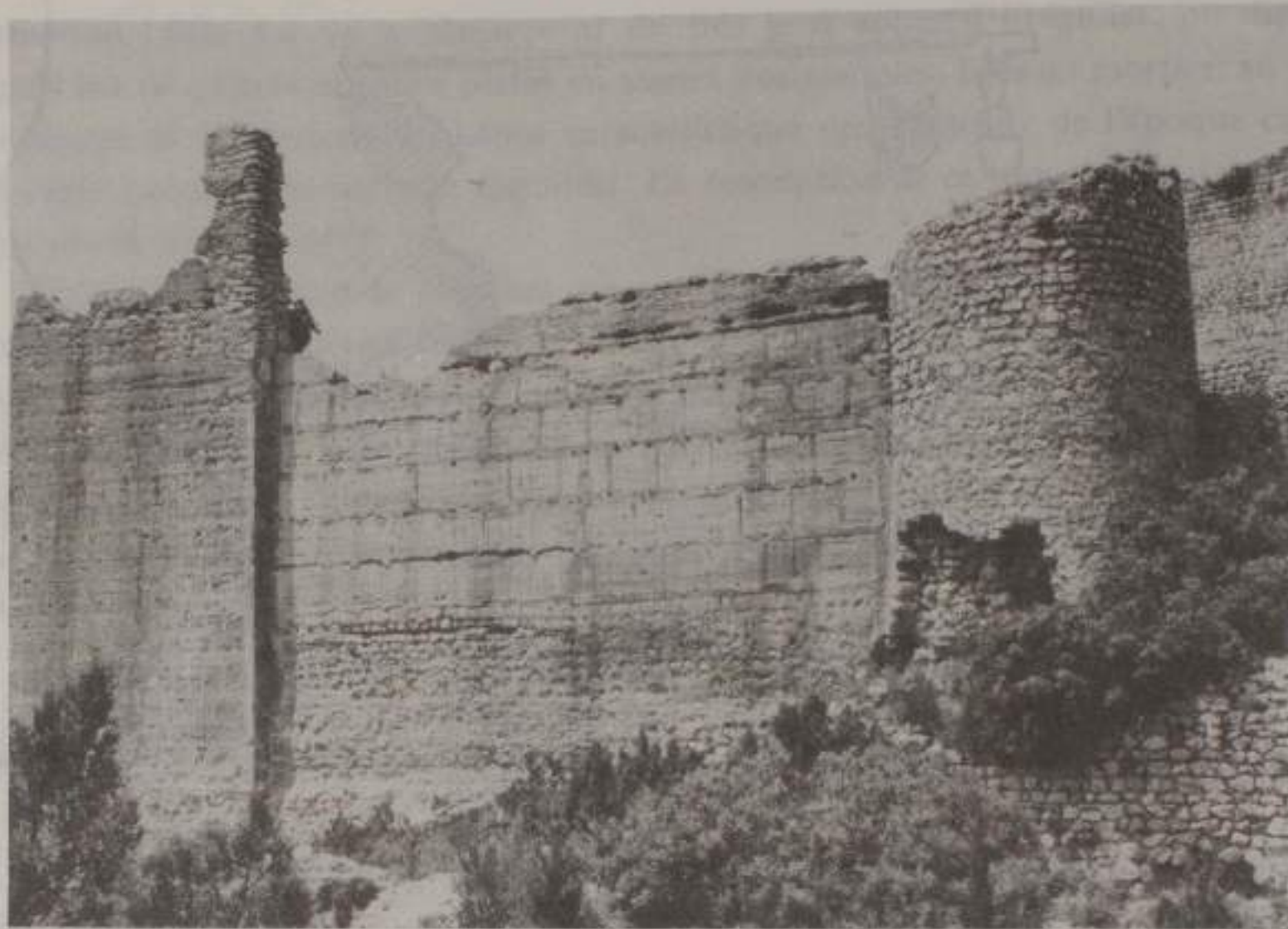
1.— ALCALA de Chivert, mur sud du château, maçonnerie de béton exécutée en coffrages.
