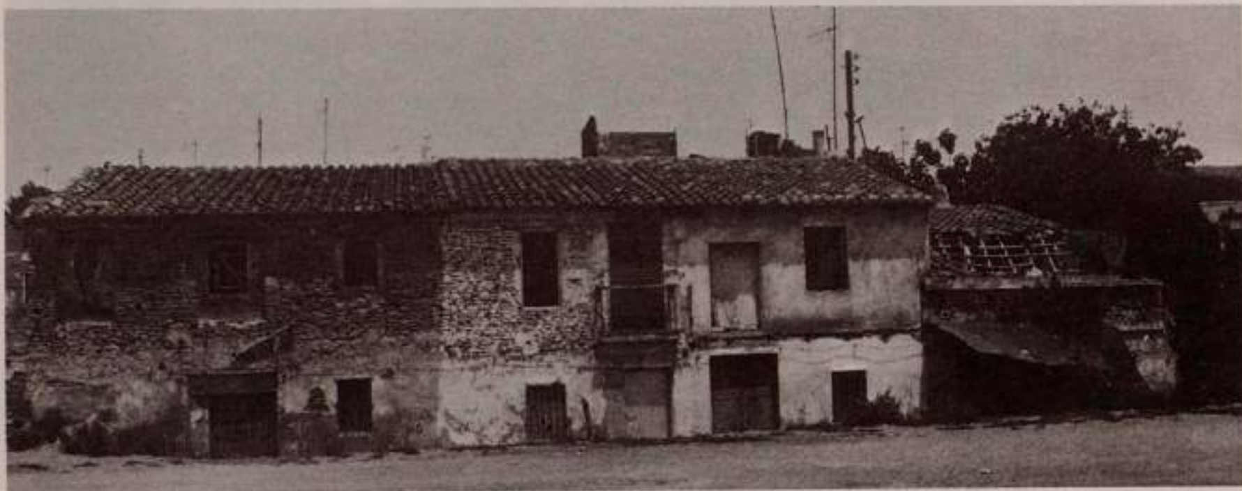
Fig. 40. Estado actual de la vivienda estudiada.
