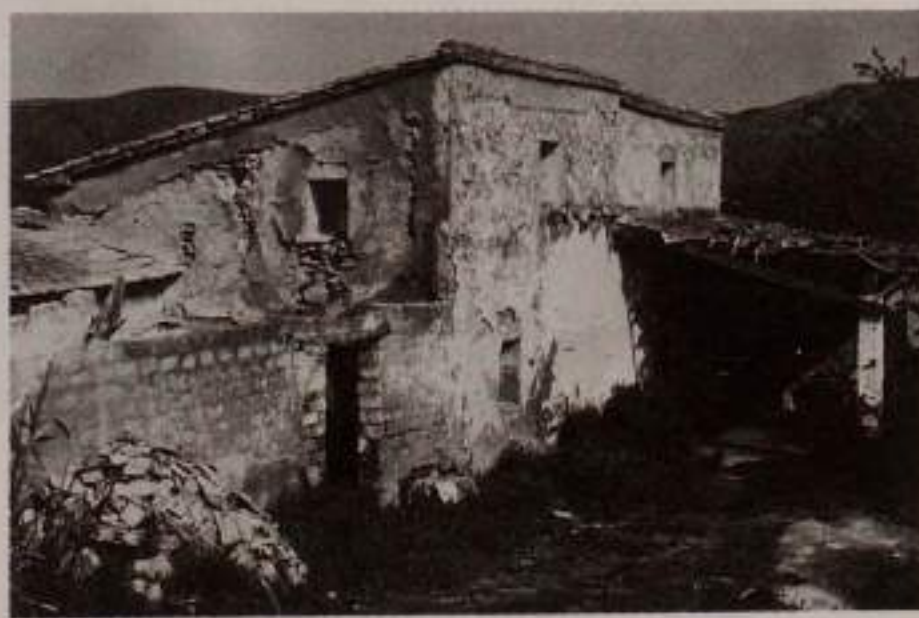
Fig. 57. Vista de la fachada.
