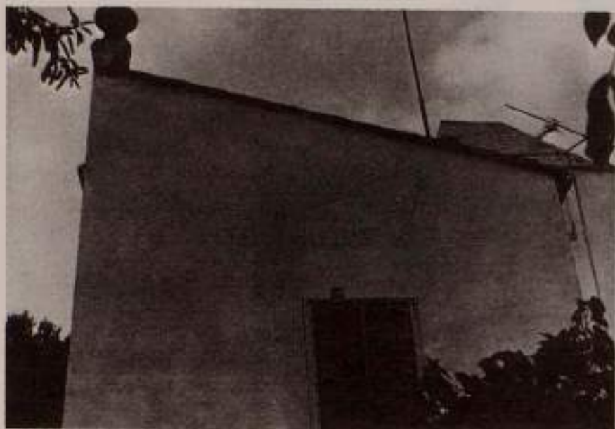
Fig. 82. Ángulo del edificio principal (casa de una cruzía). Al fondo se ve la torre que alberga a la escalera. Se puede observar la cubierta a un agua, vertiente hacia atrás, de manera que proporciona una línea horizontal sobre el plano liso de la fachada principal, solución muy típica en las arquitecturas populares y en las pequeñas casetas rurales del campo castellonense. Sobre la cumbrera podemos ver las impostas, la cronisa y los maceteros que la coronan.
