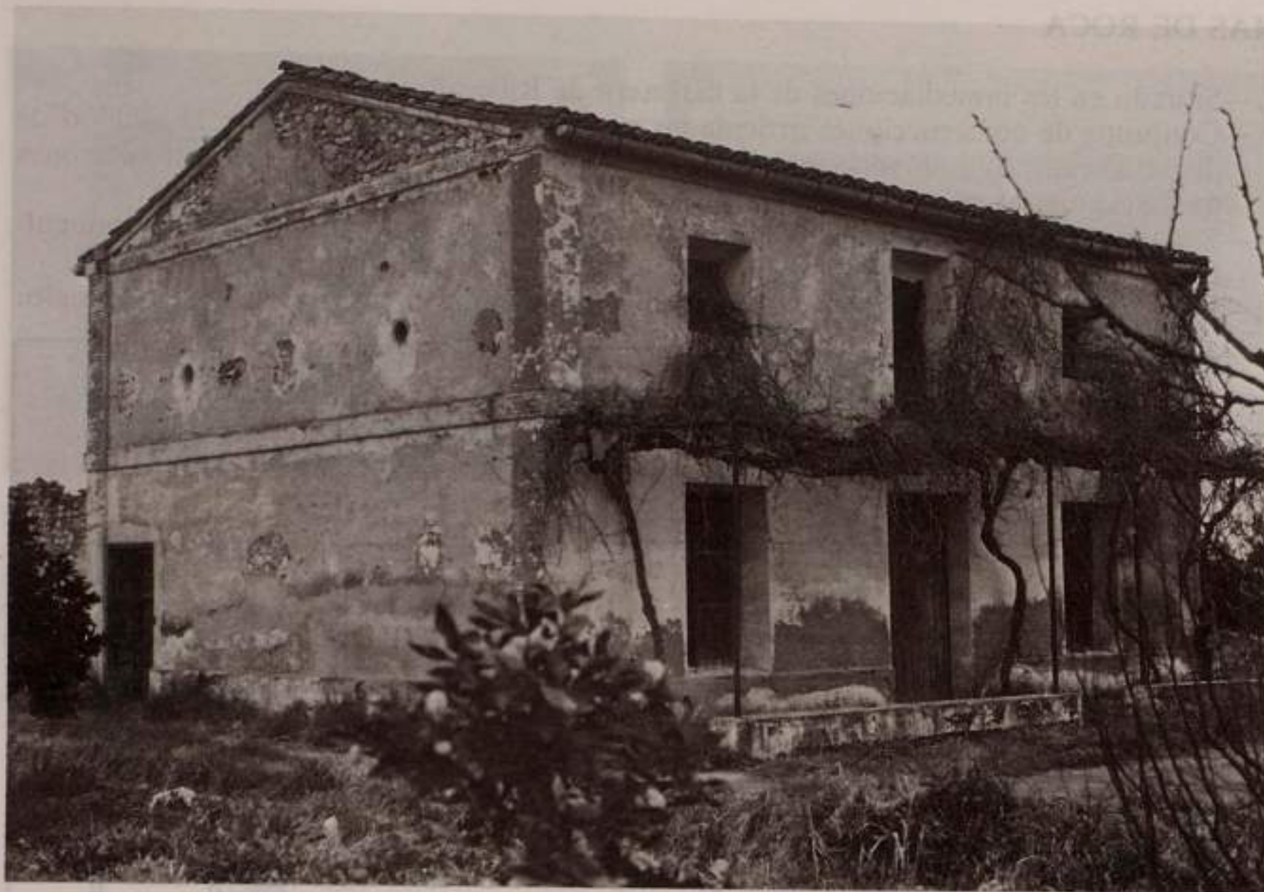
Fig. 80. Vista de la casa.
