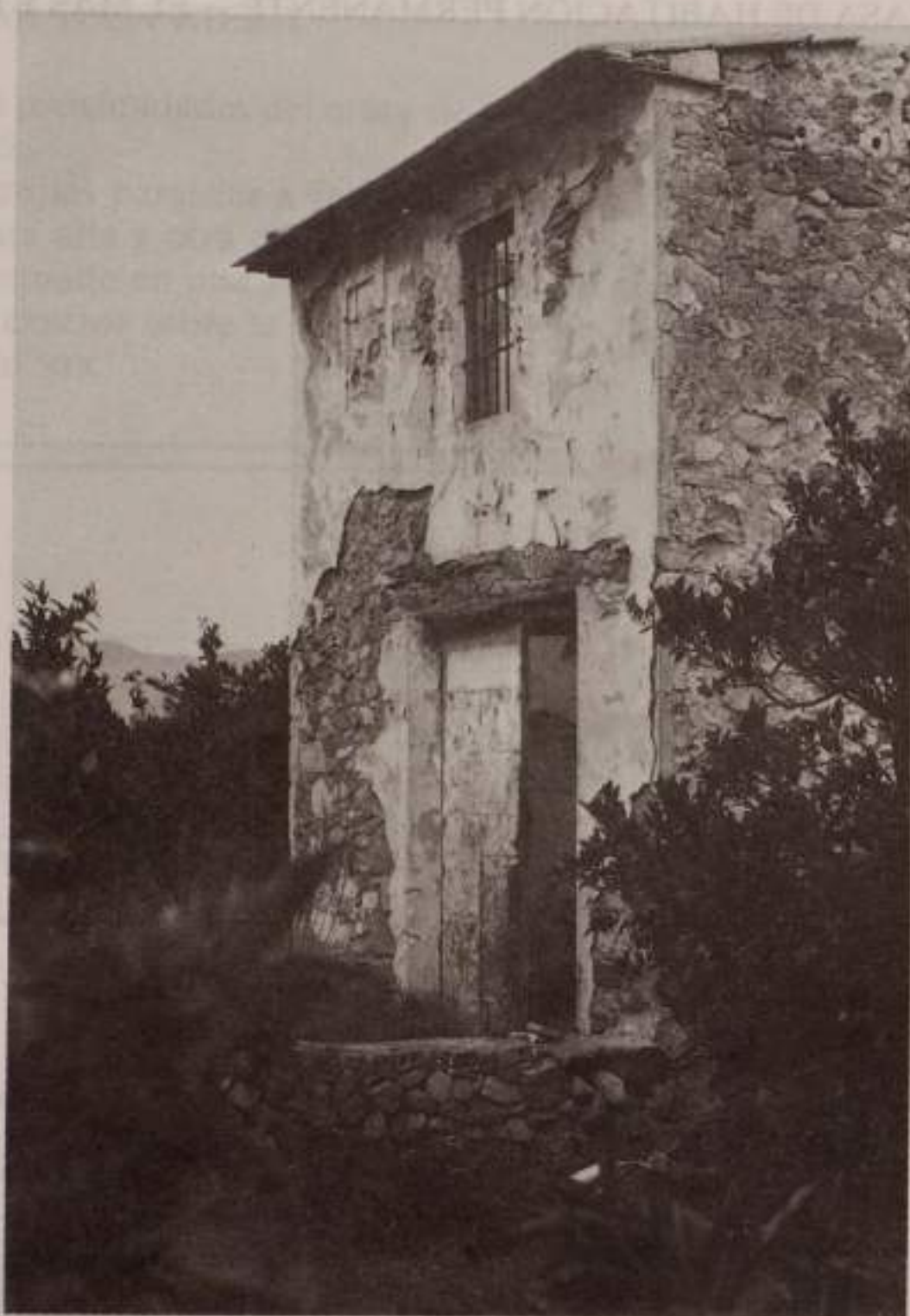
Fig. 72. Fachada principal de la casa.
