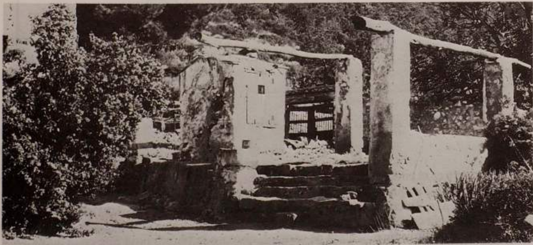
Fig. 91. Cisterna y terraza apergolada, al fondo la puerta del edificio de los corrales.
