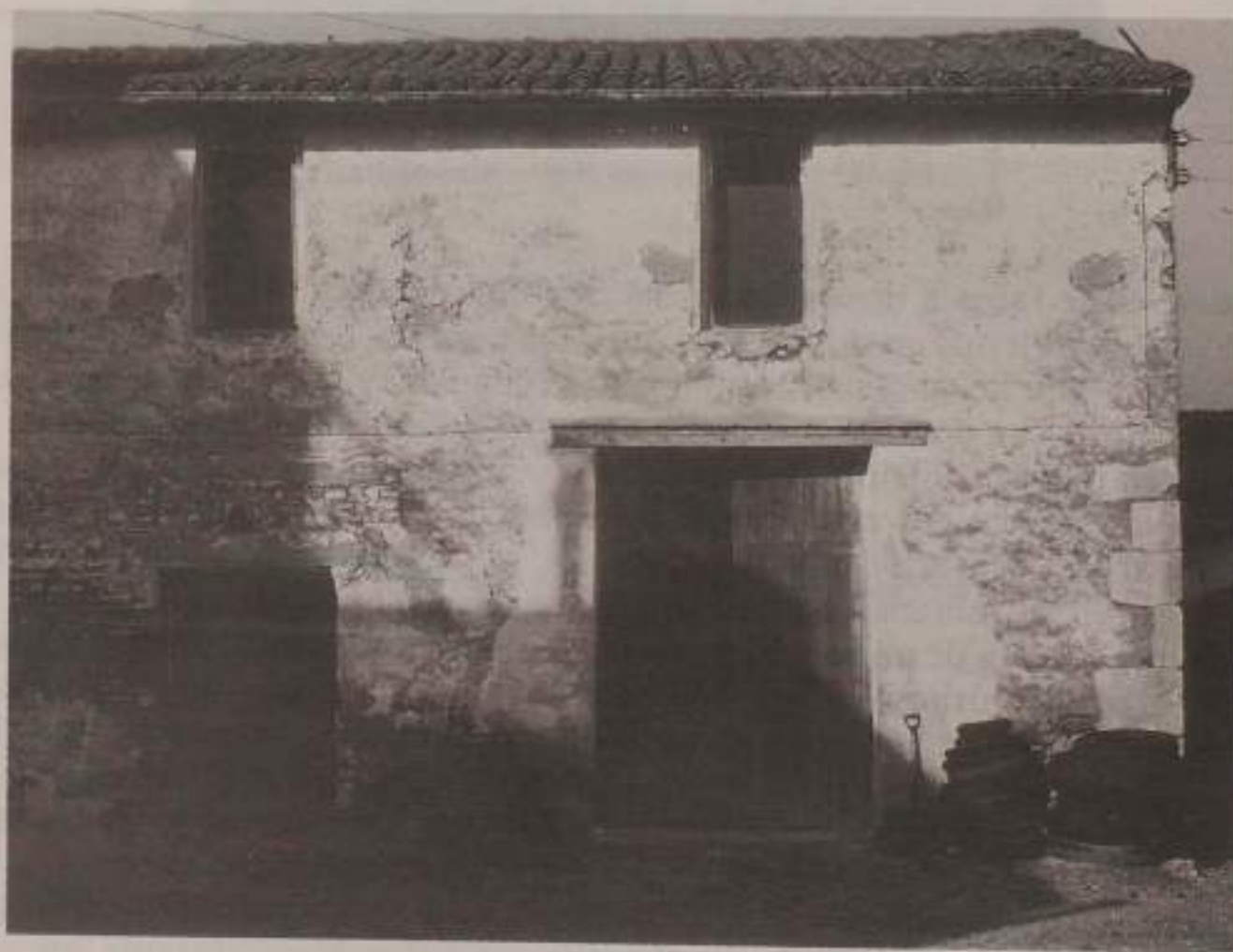
Fig. 94. Fachada al patio de uno de los edificios interiores del conjunto (3).
