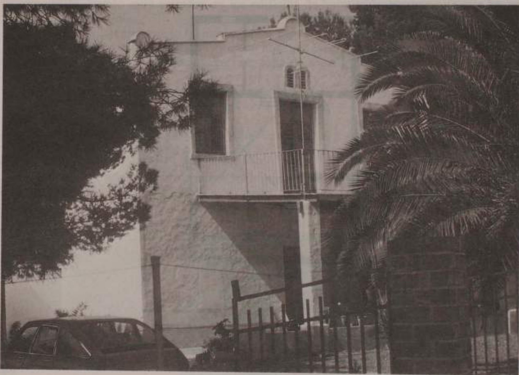
Fig. 62. Fachada actual de la Masía de Castellano. Podemos apreciar en la diferencia de fábricas las distintas etapas de su historia.
