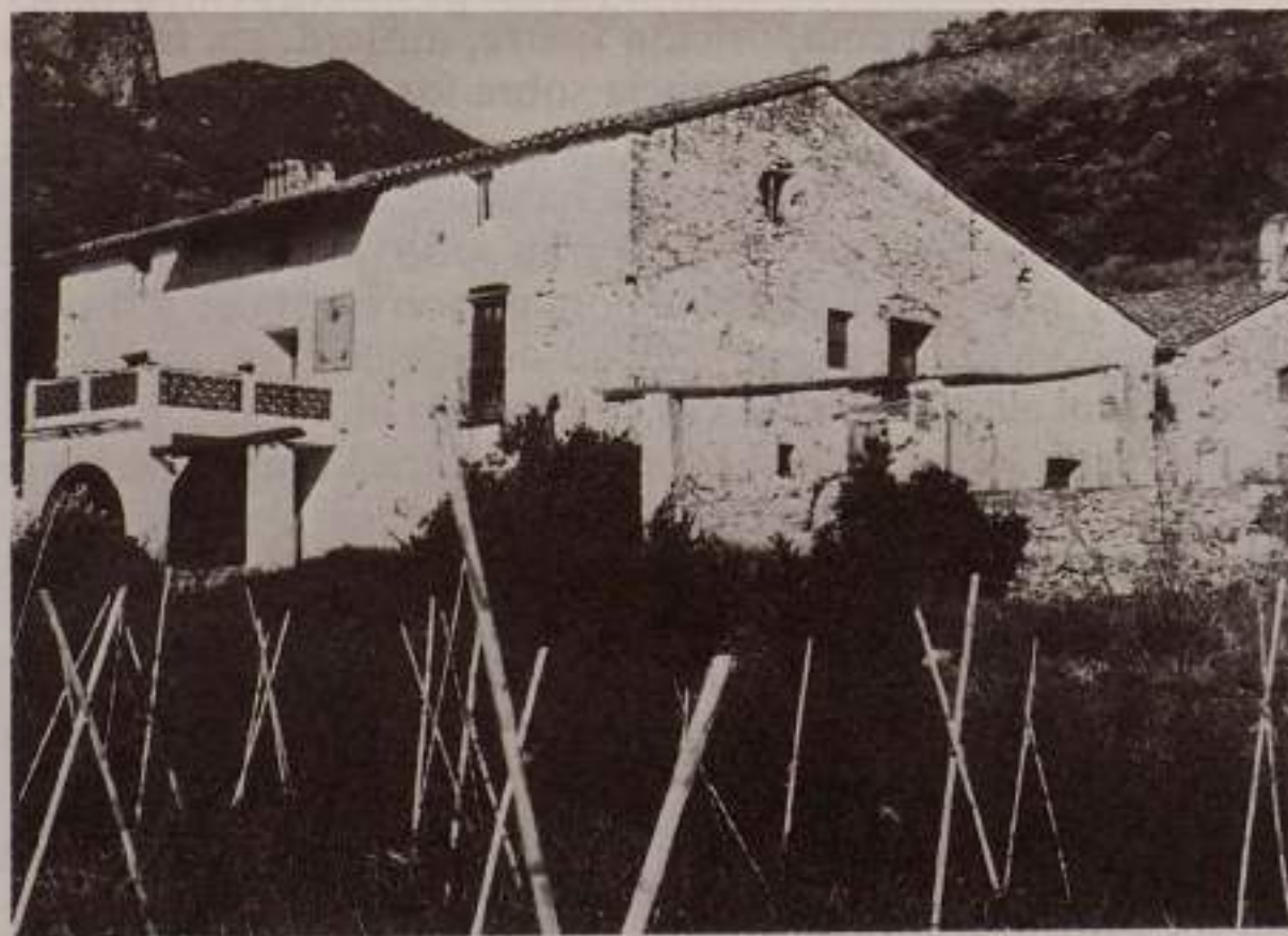
Fig. 88. Masia Salando. Vista lateral del edificio principal. A la derecha la ermita. En fachada podemos ver el porche y la terraza superior construidas a mediados de este siglo
