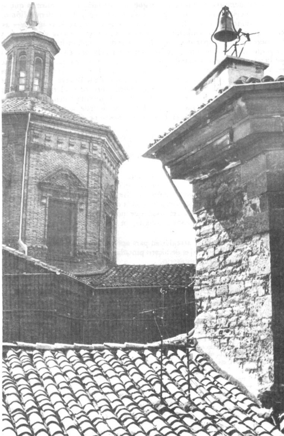
Lámina 2. Arista de empalme o intersección del testero de la fábrica neoclásica con uno de los planos del primitivo ábside gótico que permaneció en pie. Obsérvese la diferencia entre la sillería de comienzos del XIX y el antiguo aparejo medieval. Foto: Pachi González
