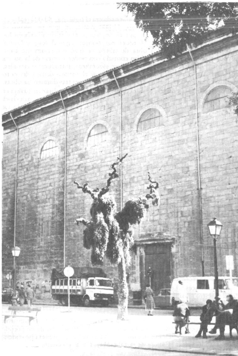
Lámina 6. Exterior de la fábrica neoclásica de la iglesia de San Lorenzo desde la plaza de las Recoletas. Este muro, junto con el del testero, fueron reedificados desde el cimiento en 1807 y 1808. Es de notar la sobriedad arquitectónica, sin otro detalle ornamental que la puerta —hoy tapiada— y las molduras de la cornisa. Foto: Pachi González
