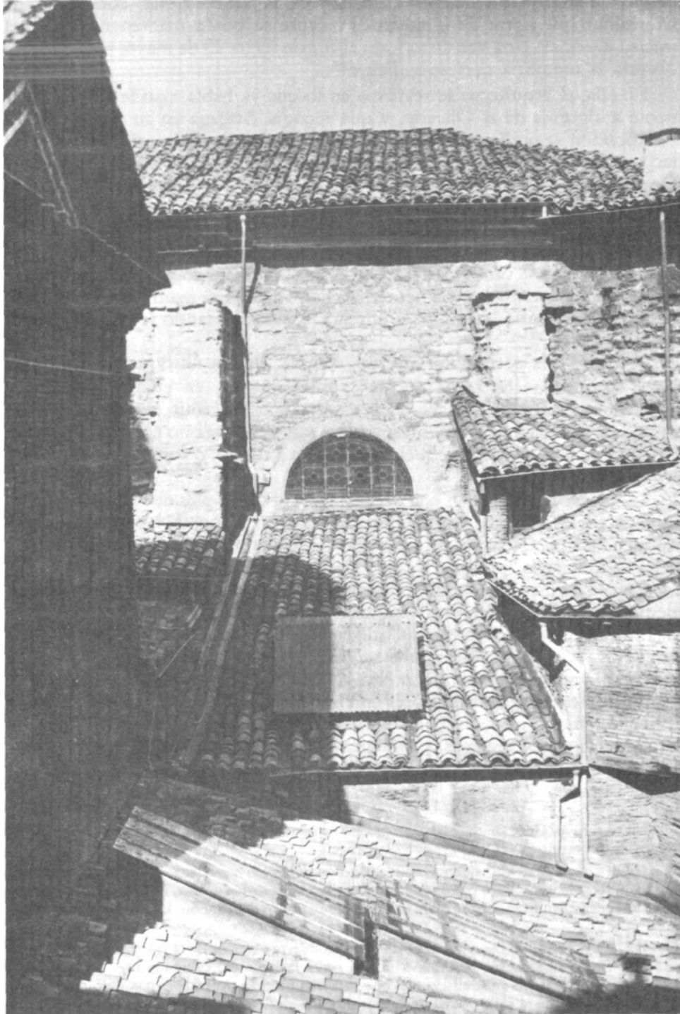
Lámina 1. Vestigios de la primitiva fábrica gótica existentes al exterior, hacia la parte de la capilla de San Fermín. Lo único que se hizo en 1807 fue rebajar la altura del muro y de la torreta de la derecha, y abrir la ventana semicircular entre los contrafuertes.
