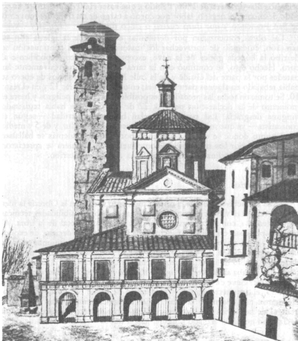
Lámina 8. Vista de la iglesia de San Lorenzo y la capilla de San Fermín en 1841. La torre corresponde a la primitiva fábrica medieval; en 1806 se acordó mantenerla en pie, adosándola a la nave neoclásica. A raíz del bombardeo de 1841 quedó seriamente dañada, por lo que hubo que rebajarle su altura en un tercio el año 185. Acuarela de Sanz y Benito en el Archivo Municipal.
