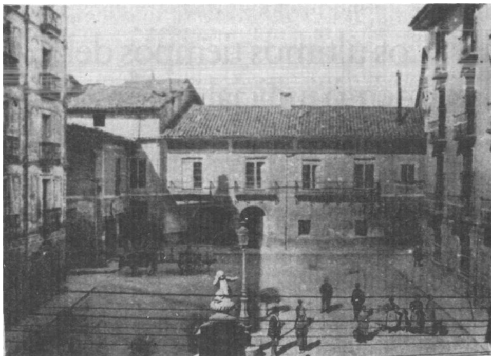
Foto 1. La antigua casona del Real Consejo, en los últimos años del siglo pasado. Construida a mediados del XVI, fue demolida en 1910. Para entonces, la Audiencia se había trasladado ya al edificio actual. Entre esas paredes se aplicó el tormento judicial a lo largo de tres siglos. (Foto: Archivo Municipal ).
