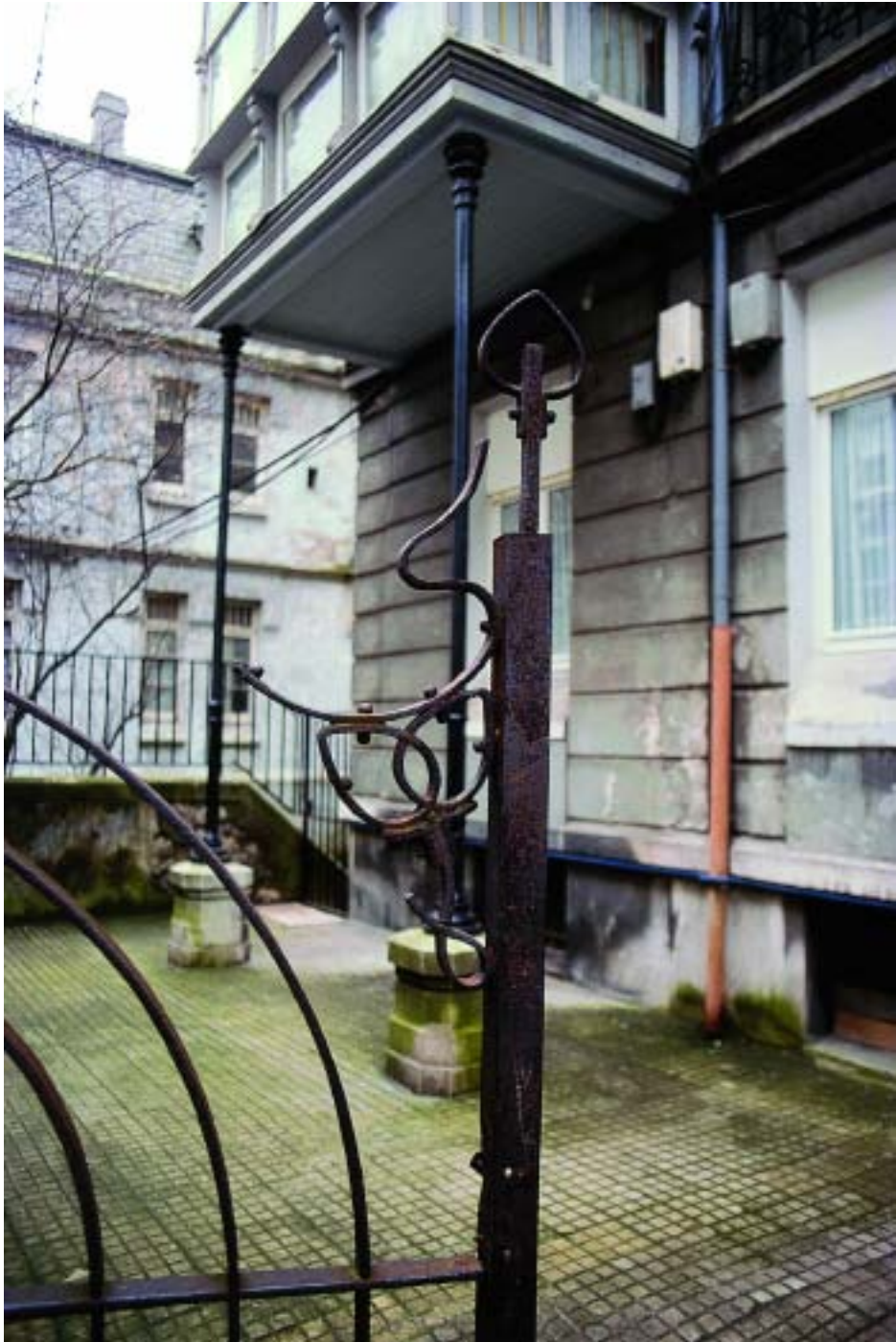
Fig. 15. Detalle de la puerta de entrada al patio de una de las casas de vecindad de Leandro Hermosilla en Santander
