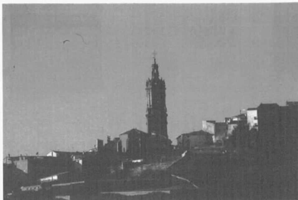
Lám. 1. Vista de Mendigorriá con la torre parroquial. (Foto C. Navalón)
