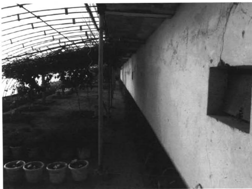
Imagen 9. Interior de invernadero. Se aprecia tubo de calefacción y ventanas de ventilación
