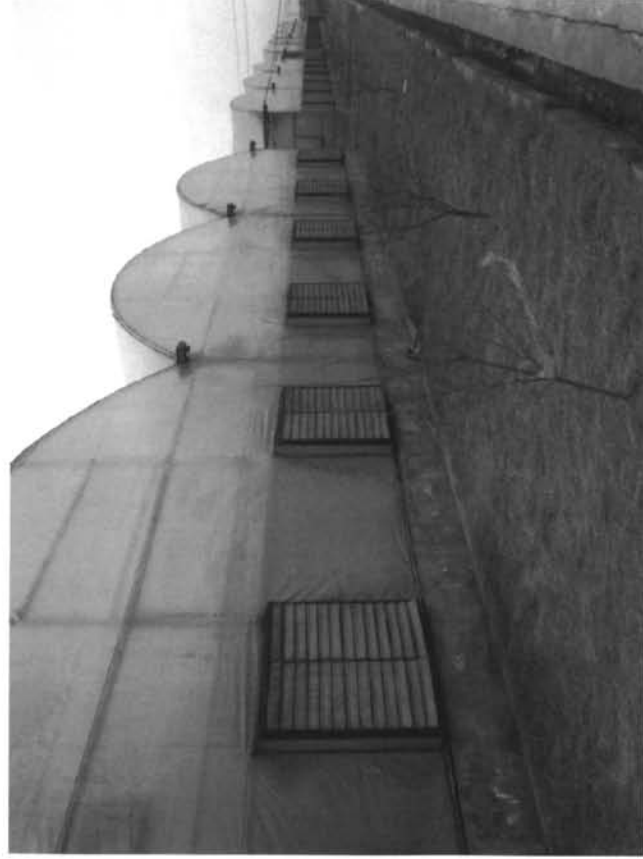
Imagen 18. Invernaderos con ventilación-refrigeración lateral y ventilación cenital
