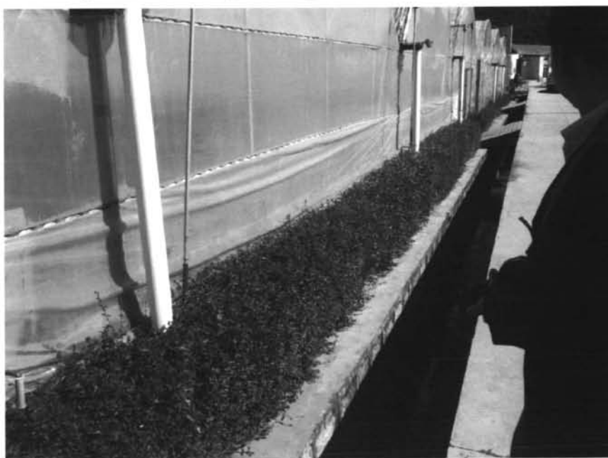
Imagen 17. Detalle de las bandas laterales de ventilación. Obsérvese el canal de riego y el "seto decorativo"
