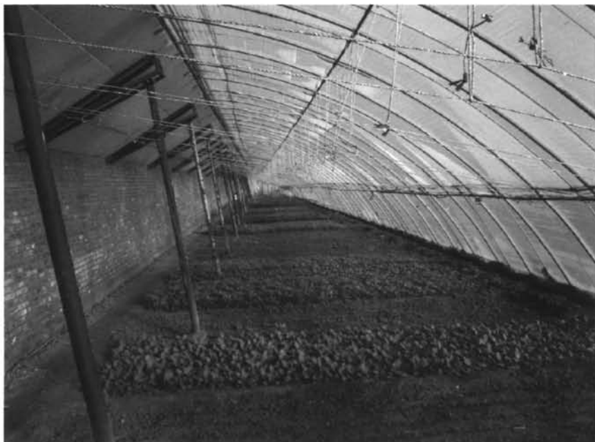
Imagen 10. Interior de invernadero sin calefacción. Temperatura exterior -5°C
