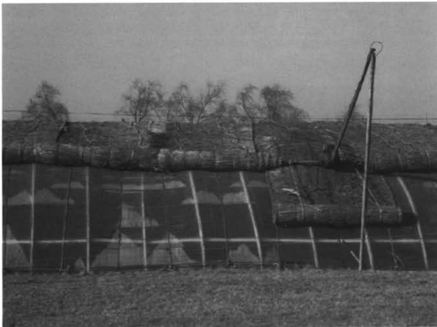
Imagen 7. Cara meridional de invernaderos tipo Pekín”. Se Está colocando la protección para evitar pérdidas de calor por irradiación nocturna
