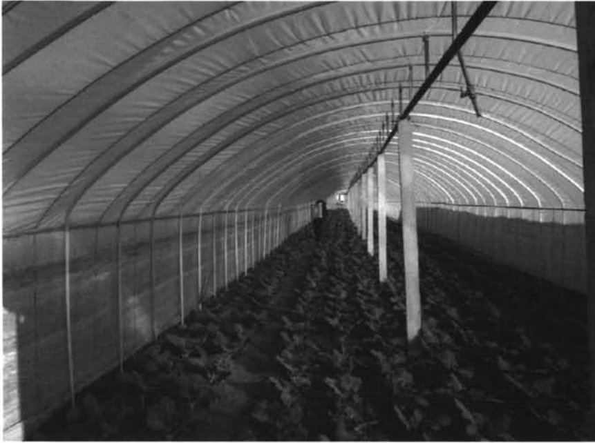
Imagen 12. Interior de invernadero "tipo Kunming"
