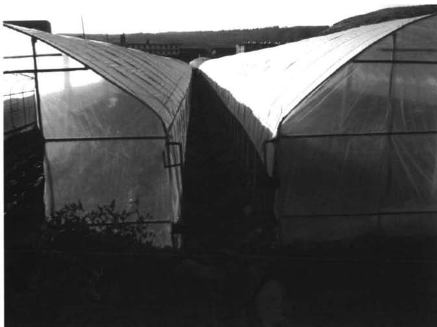
Imagen 15. detalle del canal de drenaje “tipo Kunming”
