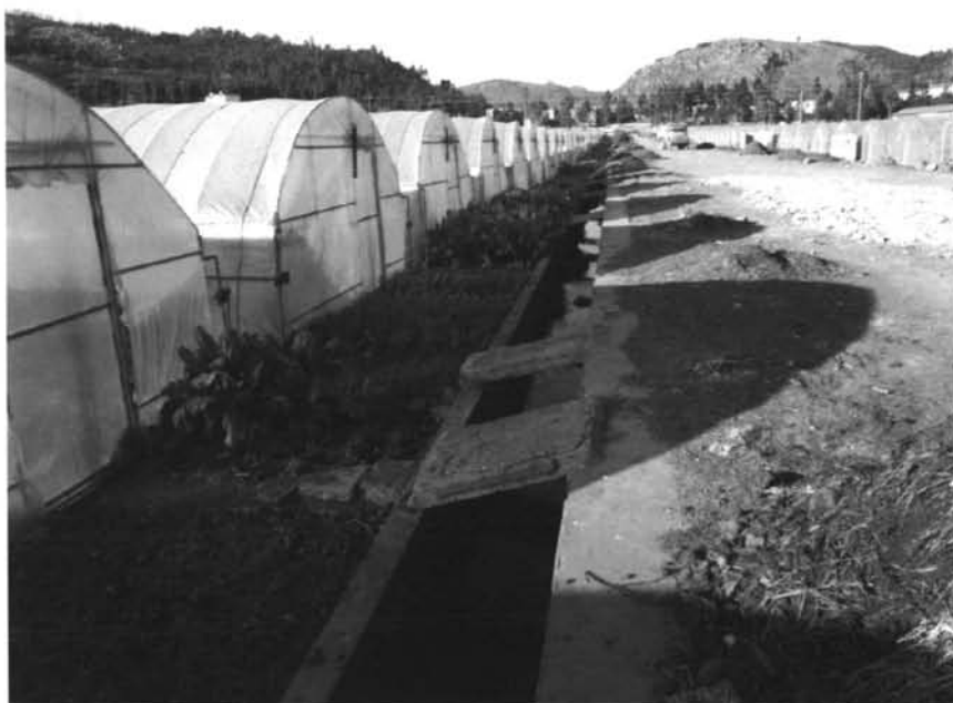
Imagen 16. Canal de agua de riego en invernaderos "tipo Kunming"
