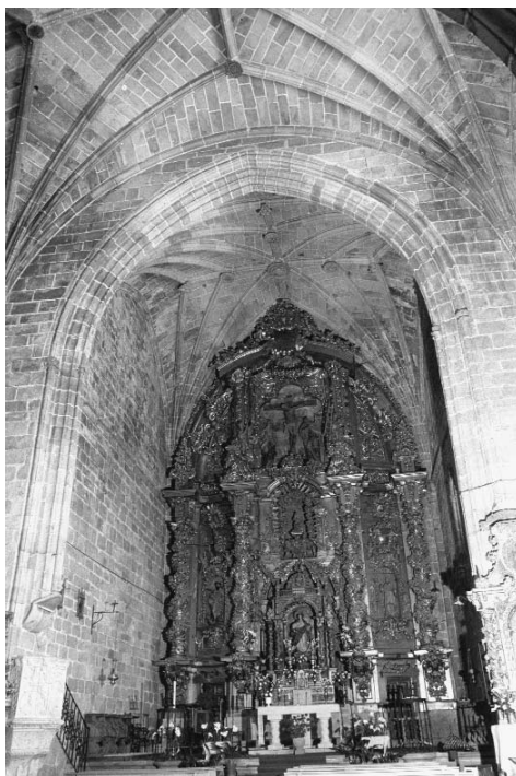
Fig. 11. Interior del ábside parroquial. Primer tercio del siglo XVI
