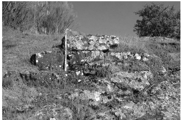
Lám. 3: Restos murarios en la parte alta del cerro.
