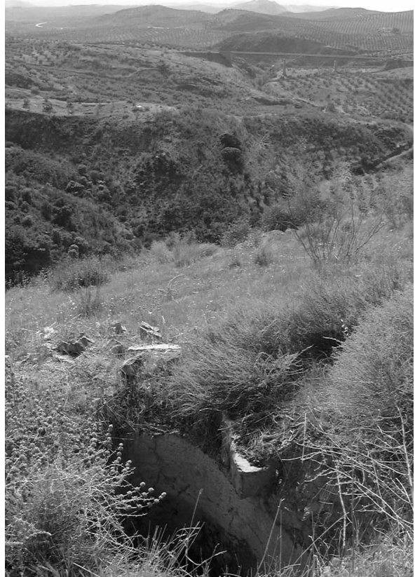
Lám. 2: Detalle del aljibe o cisterna en el yacimiento de Cabeza del Obispo.
