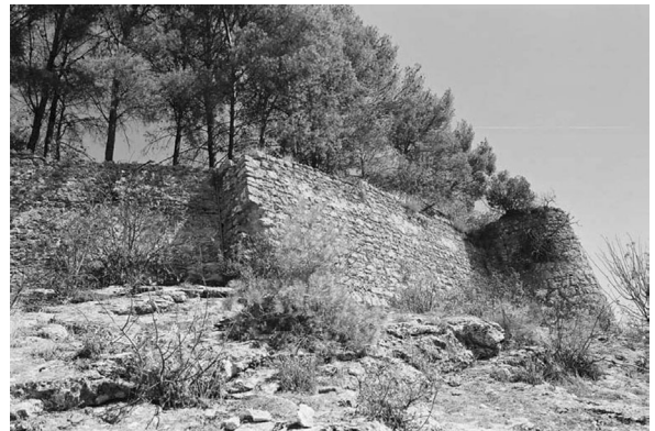
Lám. 3: Detalle del estado de conservación de la línea de muralla.
