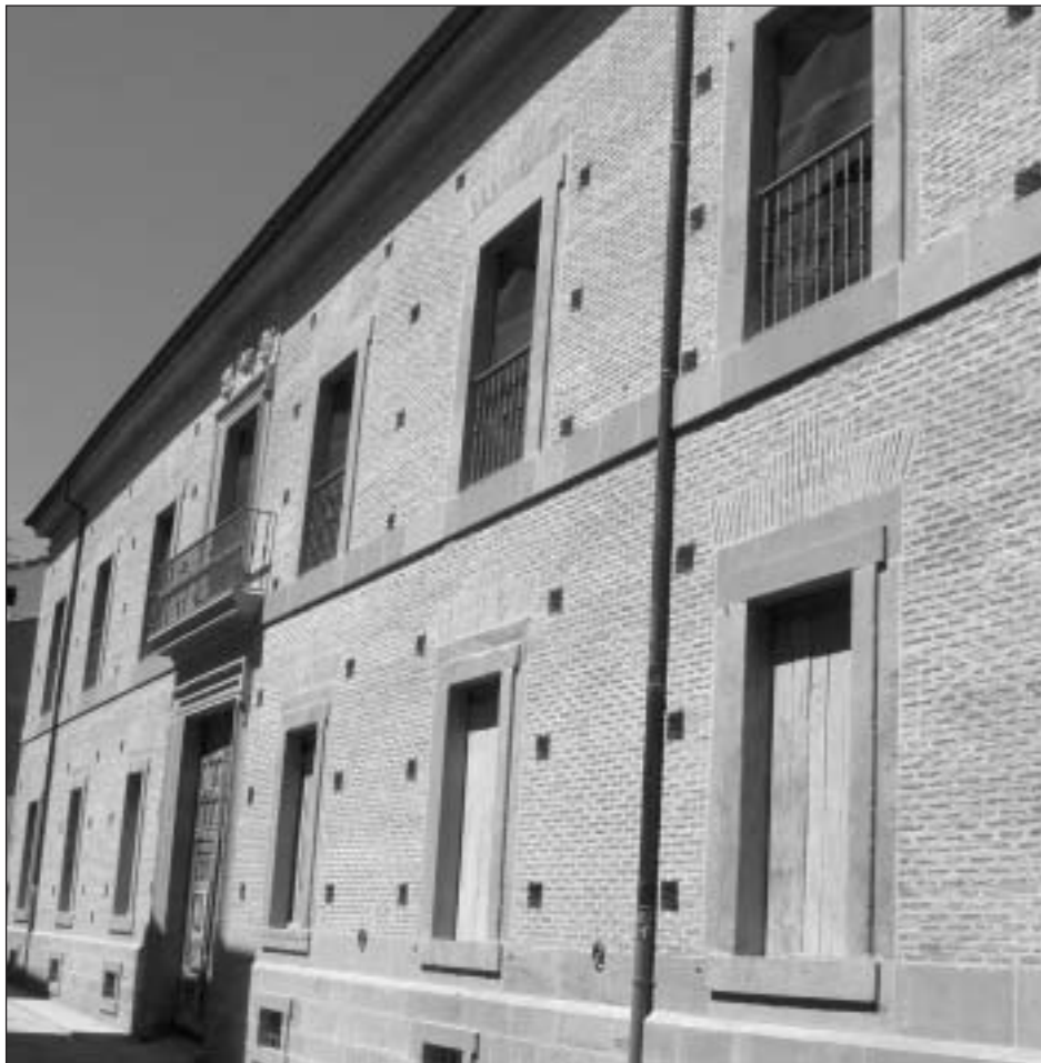
Fachada del Palacio del Gobernador a la Calle de la Rúa, una vez restaurado.
