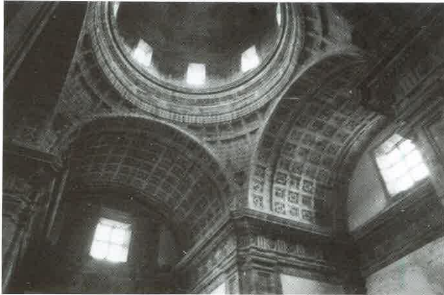
Fig. 8. Bóvedas del crucero de la iglesia del Monasterio de Monfero (La Coruña)
