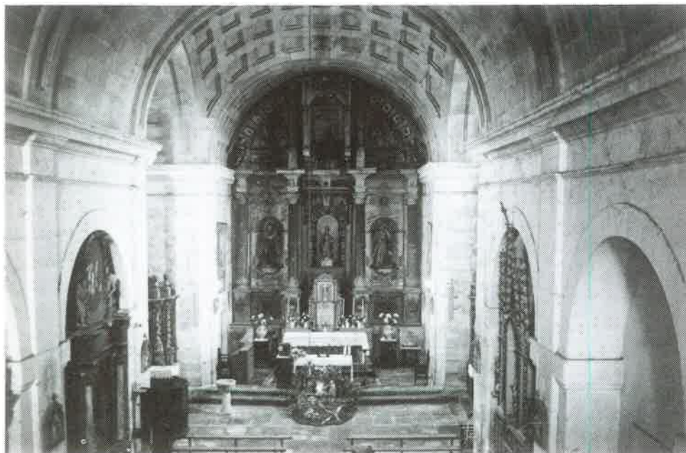
Fig. 5. Interior de la iglesia de La Mezquita
