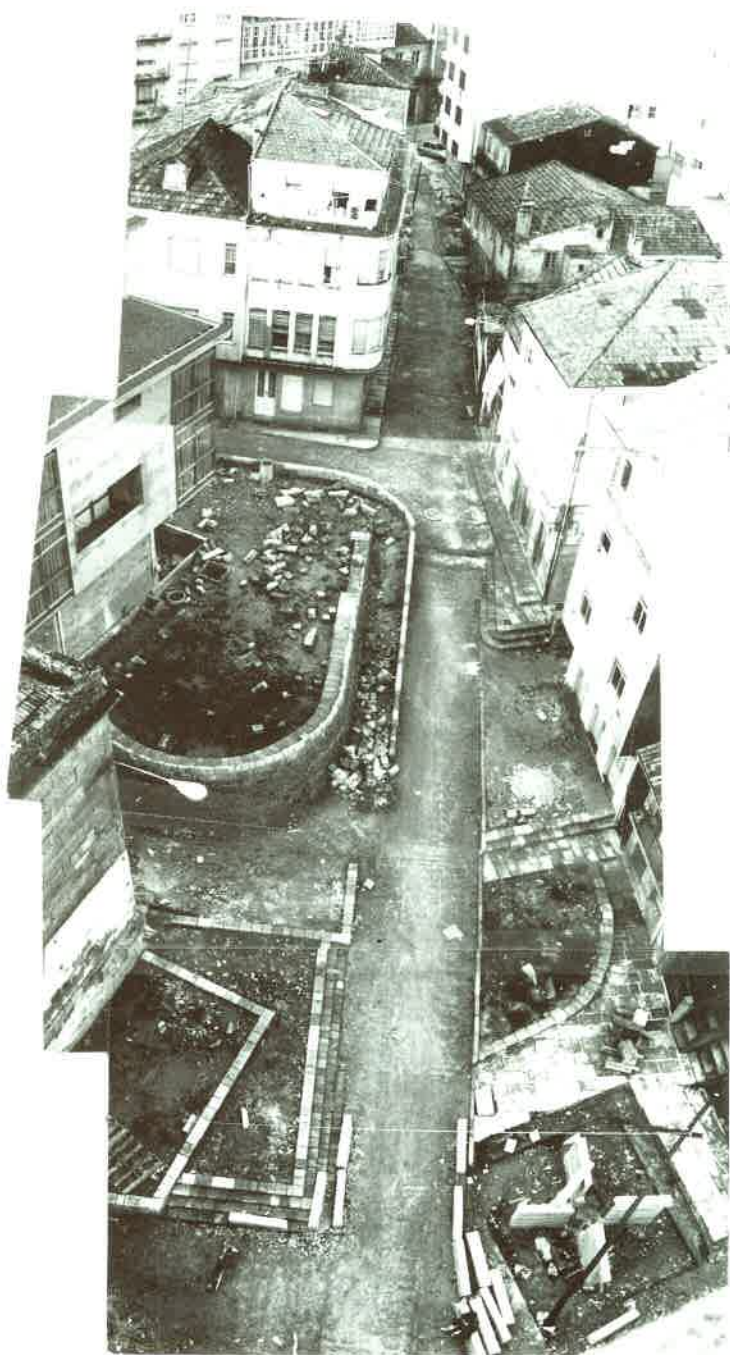
Estado de las obras en septiembre de 1984.
