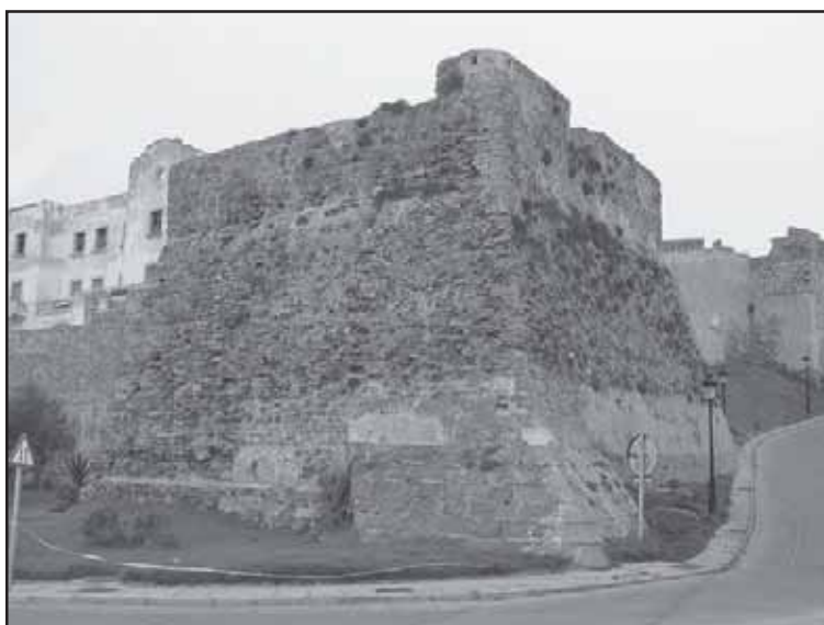
Imagen 1.- Aspecto general de la Torre de los Maderos desde la costa, antes del comienzo de los trabajos de consolidación. Noviembre de 2005.
