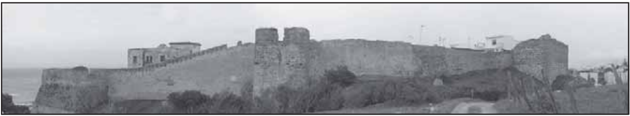
Imagen 2.- Frente oriental del recinto de la Aljaranda. La Torre de los Maderos es la situada a la izquierda (vértice sureste).
