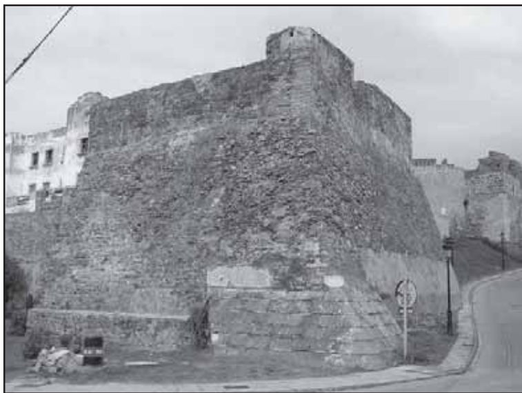
Imagen 9.- Aspecto general de la Torre de los Maderos desde la costa al finalizar los trabajos de consolidación. Abril de 2006.
