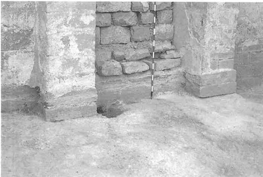
Fig. 23. a) Detalle de la ausencia de cimentación en los muros del sector norte de la iglesia del castillo, b) Detalle de cómo se asientan los muros del atrio y de la torre del homenaje sobre el suelo natural de gravas, también sin ningún tipo de cimentación (fotos: J.A. Benavente y M.A. Zapater).
