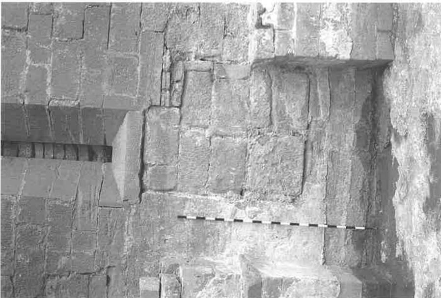
Fig. 18. a) Detalle de la puerta cegada que comunicaba la sala 1 o refectorio con la sala capitular. b) Detalle de uno de los huecos o nichos del muro sur del refectorio posteriormente cegado (fotos: J.A. Benavente y M.A. Zapater).
