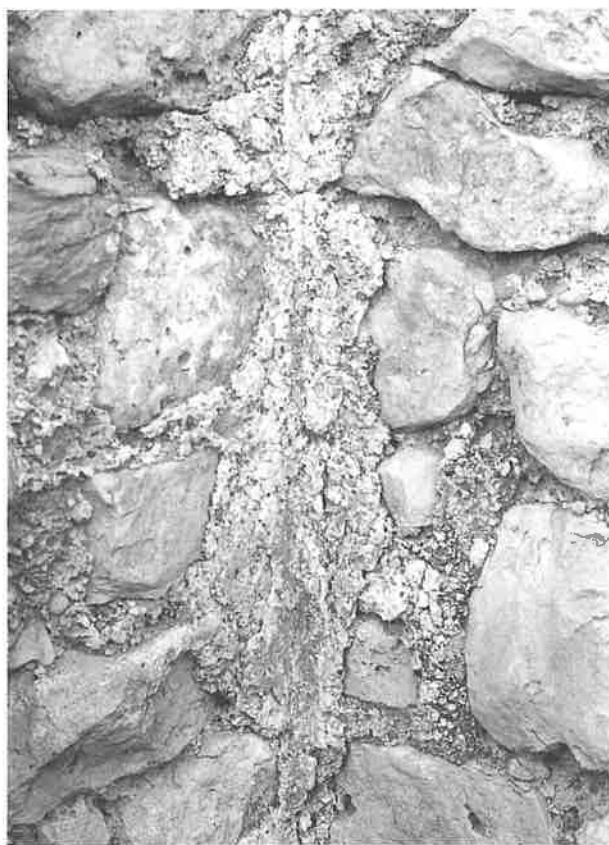
Lám. 2. A. Aspecto actual del aljibe de Alcañiz el Viejo. B. Detalle del enlucido conservado en uno de los ángulos del aljibe (fotos: J.A. Benavente).
