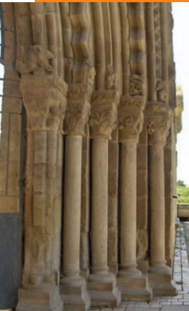
NAVARRETE: DETALLE DE COLUMNAS Y ARQUERÍA DE LA PORTADA DEL ACTUAL CEMENTERIO.
