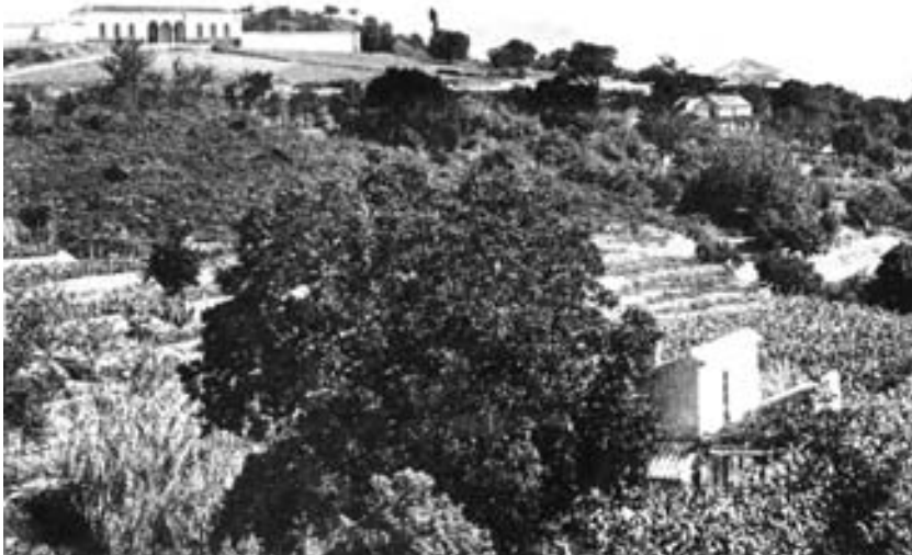
Primera imagen del Cementerio de San Fernando de Coín realizada por Miguel Salgado Vázquez, 1916-1918.
