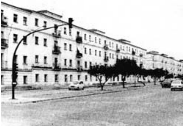
Barriada de Carranque. Aspecto de fachada principal.
