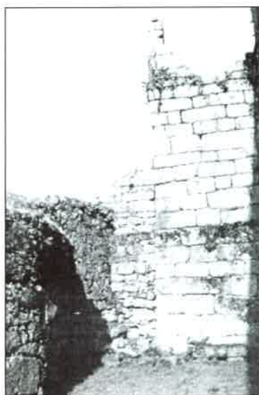
Fig. 11: Contrafuerte derecho, interior.
