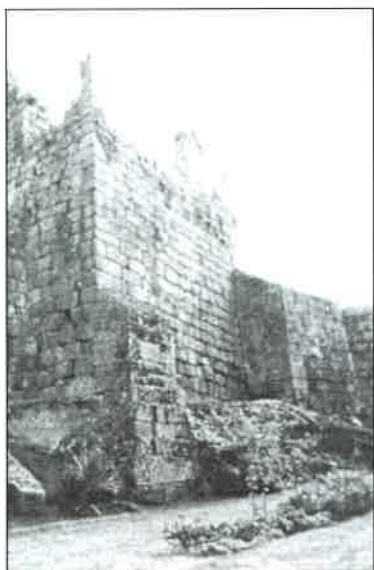
Fig. 9: Contrafuertes de la torre.
