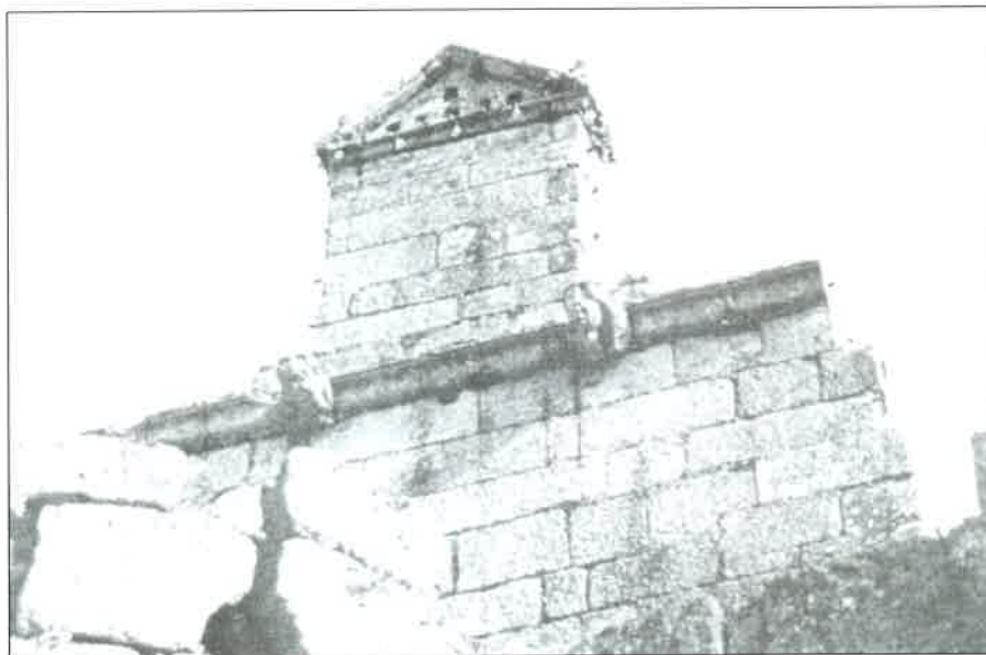
Fig. 20: Chimenea del castillo, exterior.
