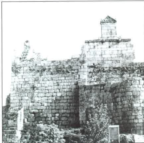
Fig. 7: Muro Noroccidental de la fortaleza con la antigua torre de S. Ginés.
