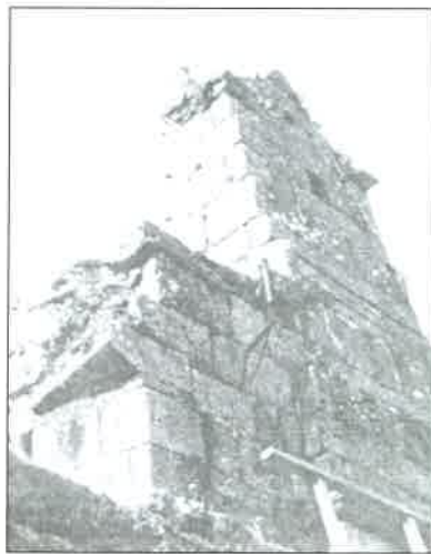
Fig. 15: Chimenea: interior, detalle del muro.
