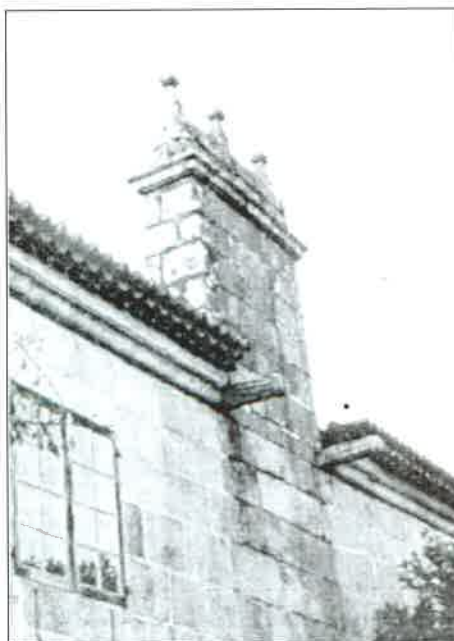
Fig. 21: Chimenea del Pazo de Castrelo (Sta. María de Castrelo de Miño).
