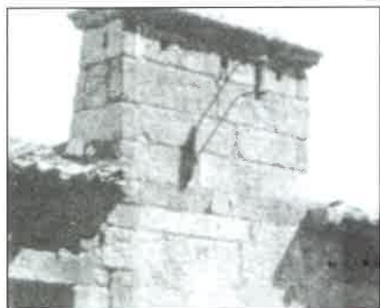
Fig. 24: Chimenea de la Casa de Troncoso (Astariz). [Foto: M a Teresa Rivera Rodríguez].
