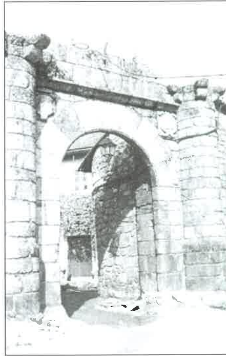
Fig. 36: Puerta Nueva de la Villa.
