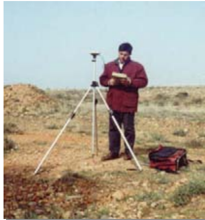
Figuras 1 y 2 . Operaciones topográficas de replanteo y control de obras industriales y de edificación
