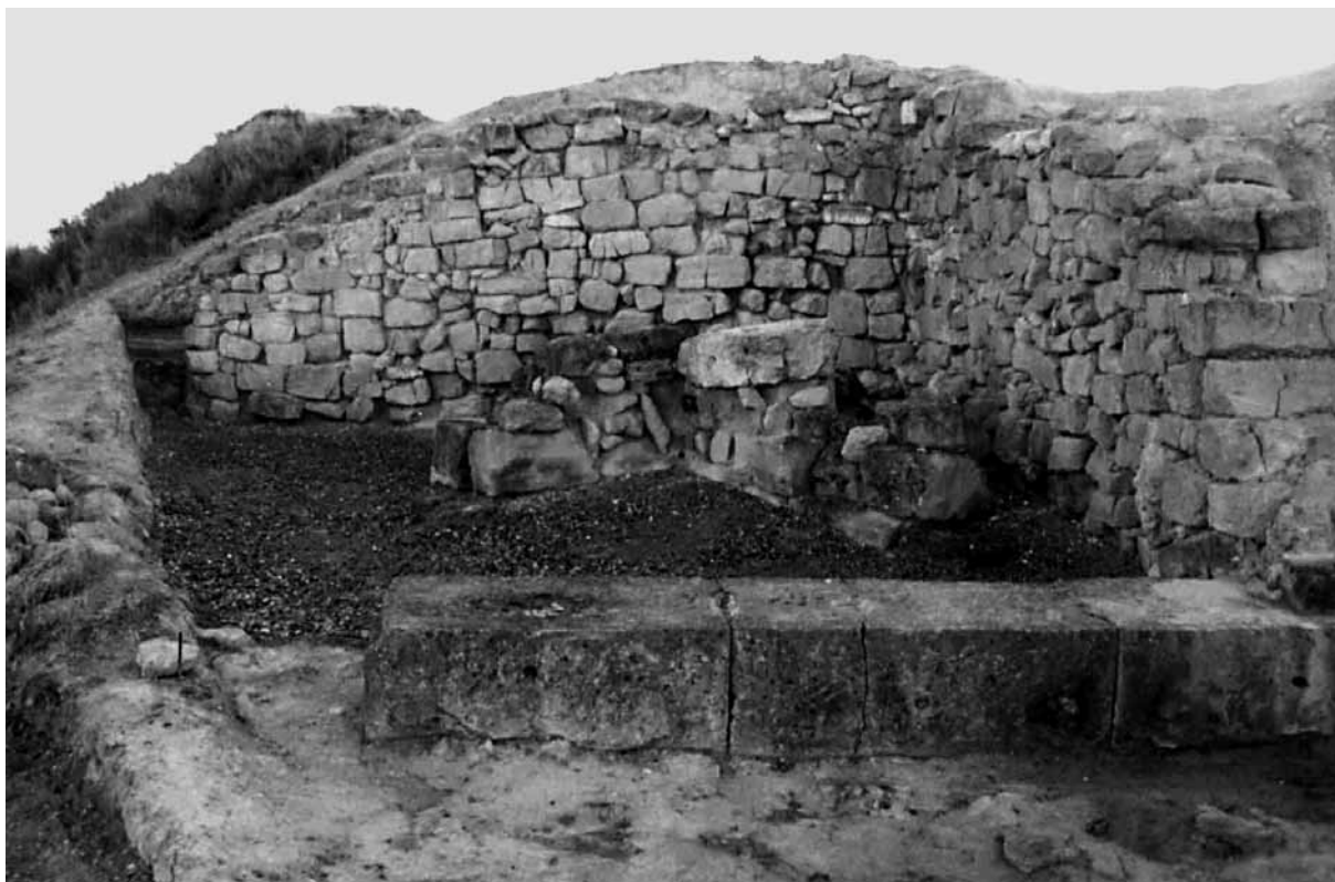
Figura 8. Sillares almohadillados, en primer término, y muros de opus vittatum , en segundo término, ya consolidados.
