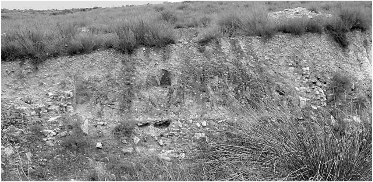
Figura 12. Restos de una gran habitación que se conservan en el corte de la carretera comarcal La Almunia-Calatorao.
