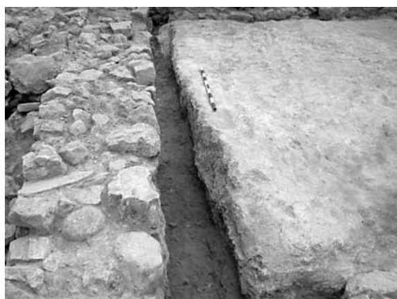
Figura 8. Detalle de la zanja de cimentación (UE 11021) del muro UE 11004.
