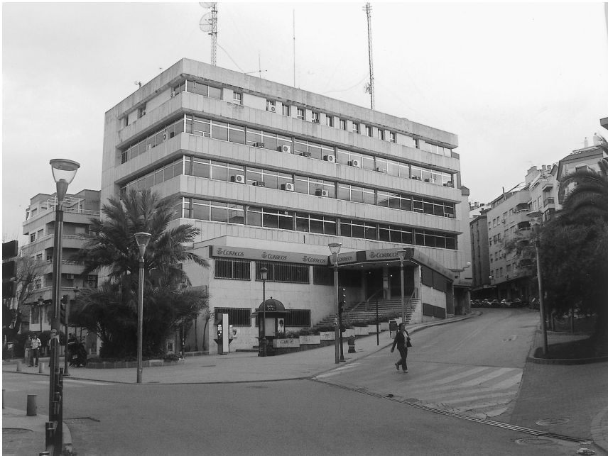
Antiguo emplazamiento del convento de San Agustín. Hoy, edificio de Correos y calle pública.
