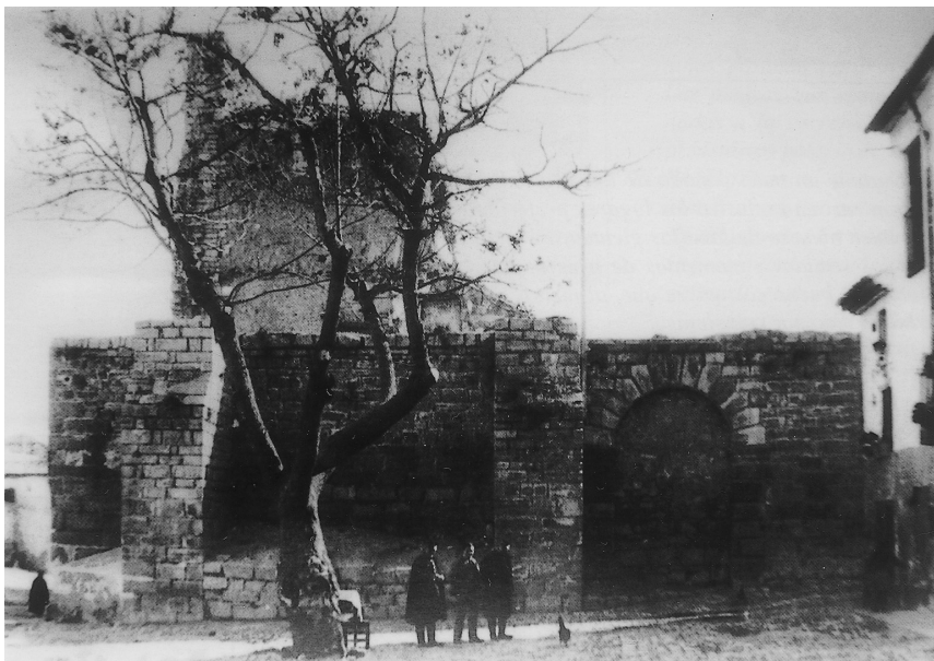
Lateral del convento de San Agustín, iniciada ya su demolición en 1922. (De Jaén en Blanco y Negro ).
