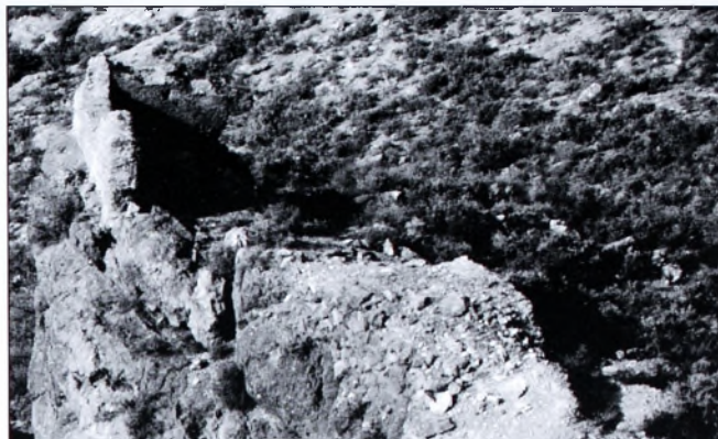
Lám. 9. Torre albarrana.
