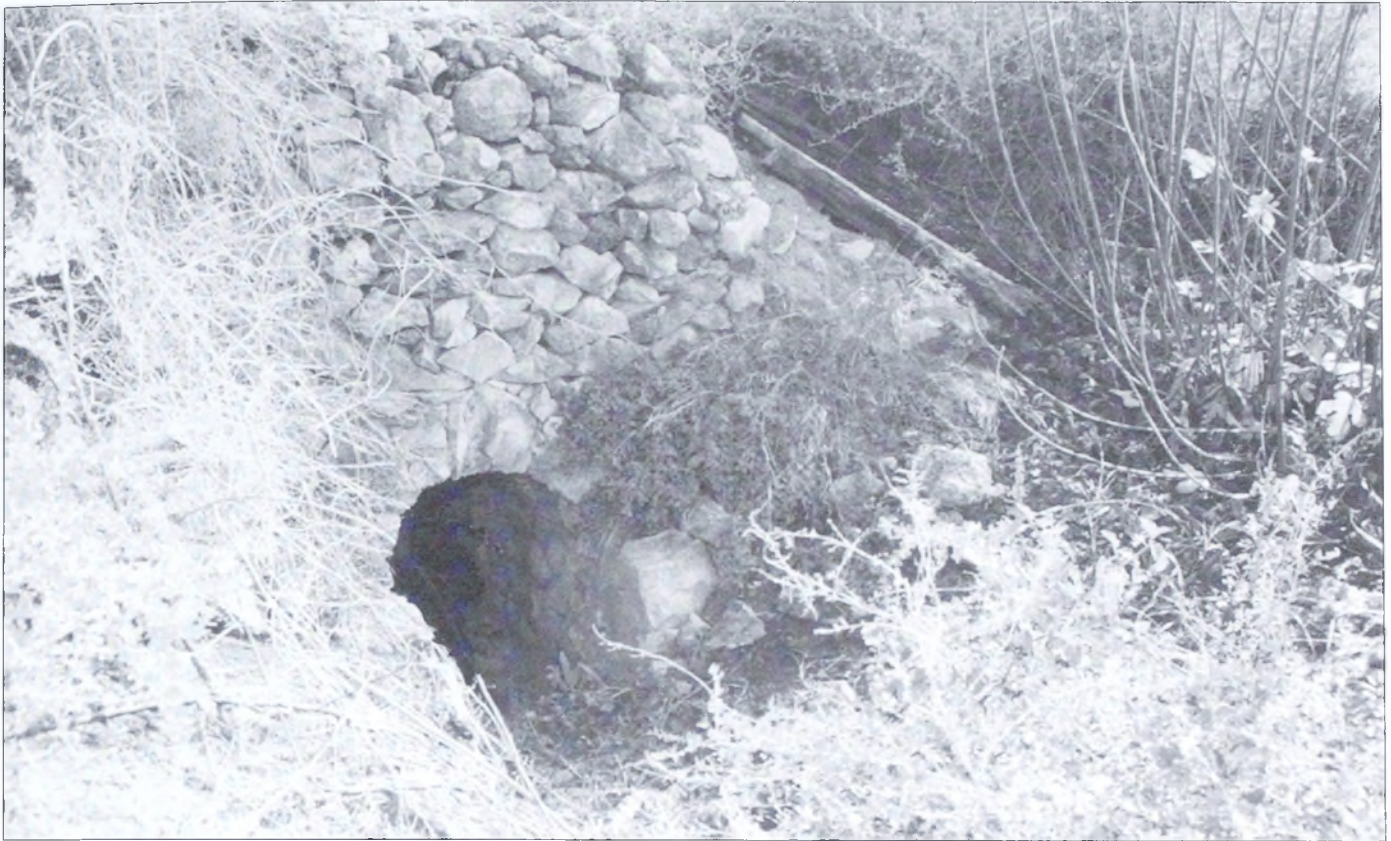
Lámina 7. Galería de limpia y último pozo de la fuente de La Quinta.
