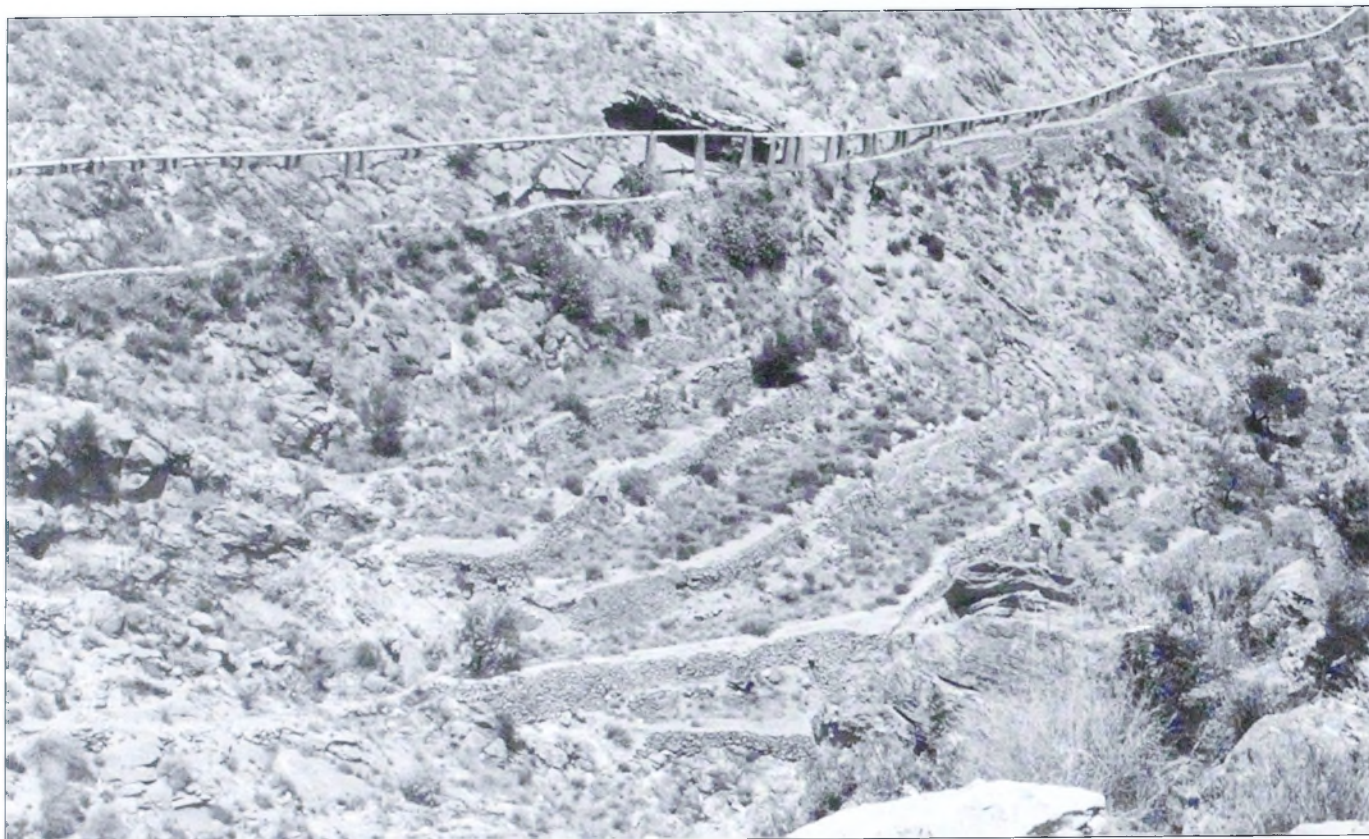
Lámina 4. Acequia de Gatuna, con las paratas previas a su puesta en funcionamiento.
