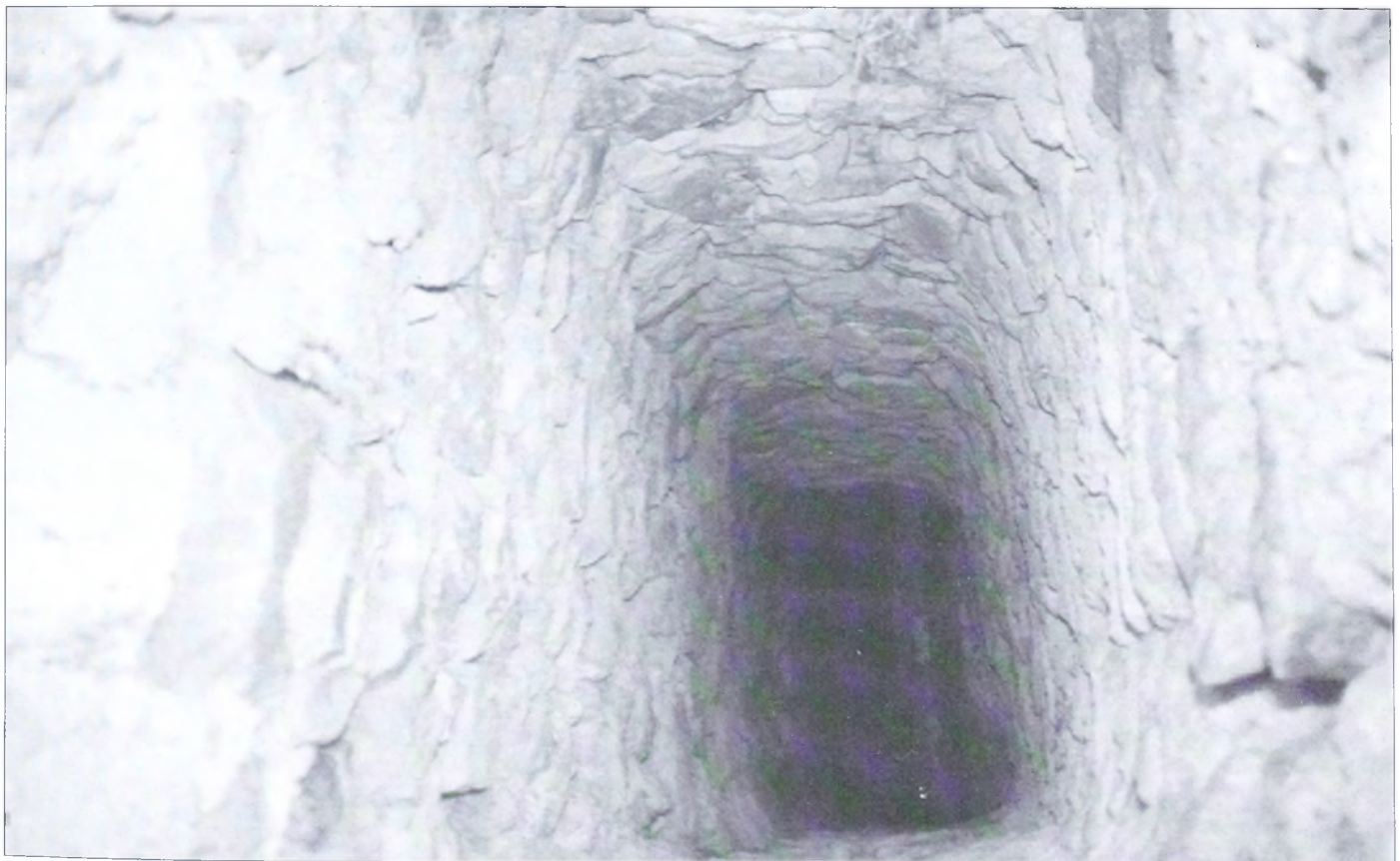
Lámina 8. Pozo inicial o madre de la fuente de La Quinta, impresionante obra de piedra en seco.
