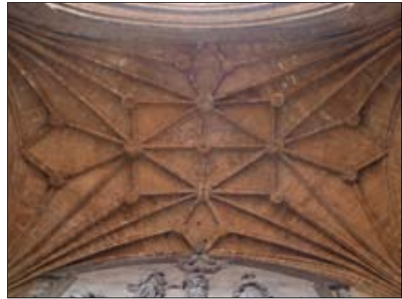
■ Imagen 4. Bóveda del tramo central del pórtico de la catedral de Oviedo. (foto Carmen Labra).
