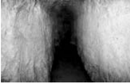
Fotografía nº 5. Galería subterránea para la captación de agua. Mina de la Canaleja.
