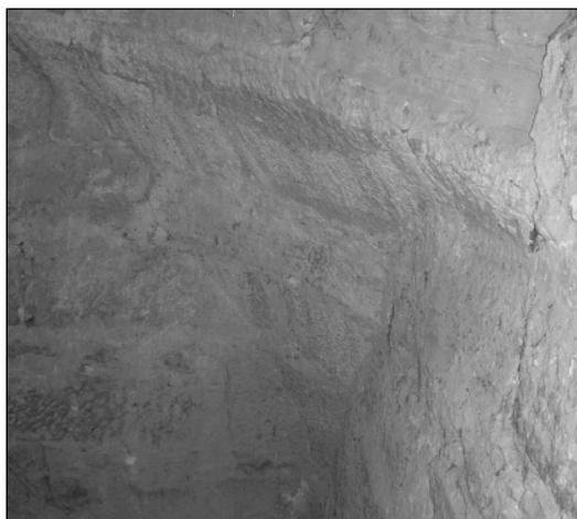
Figura 12.- Detalle de la torre. Pechina en transición del cuerpo cuadrado al circular.
