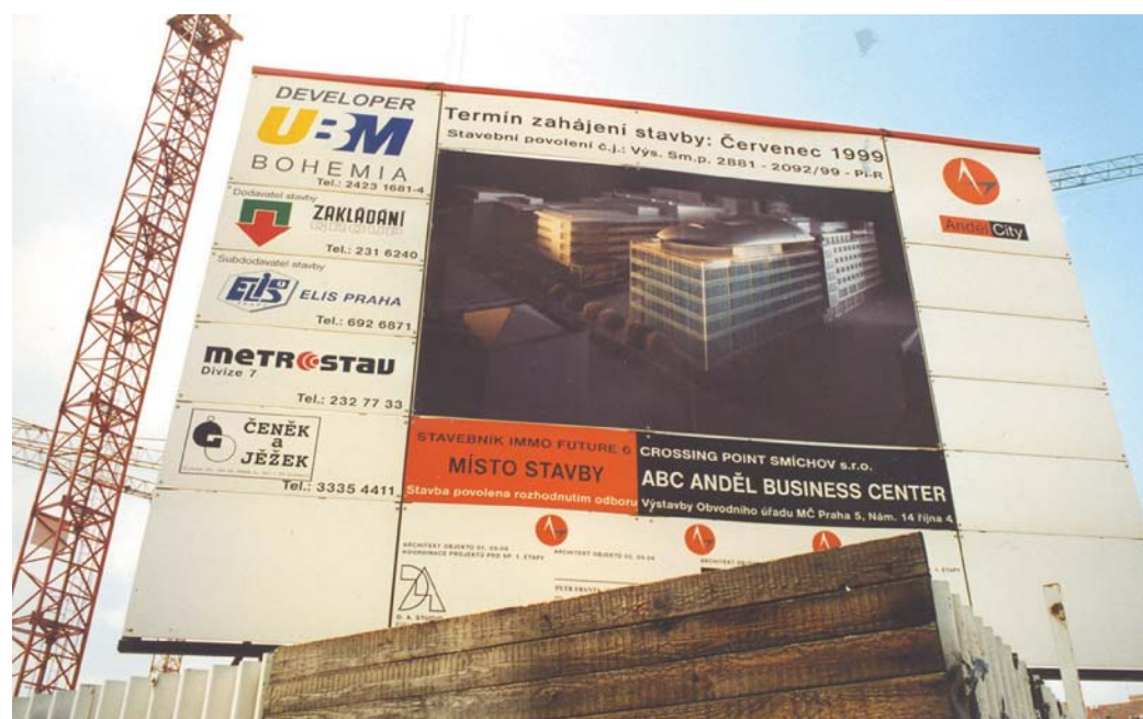
Figura 7: Múltiples transformaciones en Smíchov. Contemplamos en Smíchov la irrupción de un tejido completamente nuevo, al construirse un complejo terciario sobre el terreno de lo que otrora fuera una industria de exportación. En Smíchov, como casi en todo Praga, estas profundas transformaciones, que comienzan en la segunda mitad de la década de 1990 y redefinen la capital checa, apenas fueron discutidas en conjunto. Fuente: MWG, mayo 2000.
