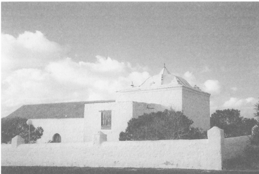
3.2.1. Lado de la Epístola con detalle del Presbiterio y cubierta del mismo
