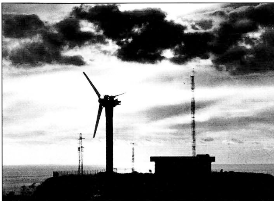
Primera instalación eólica de Tarifa. (Foto I. Sena).
