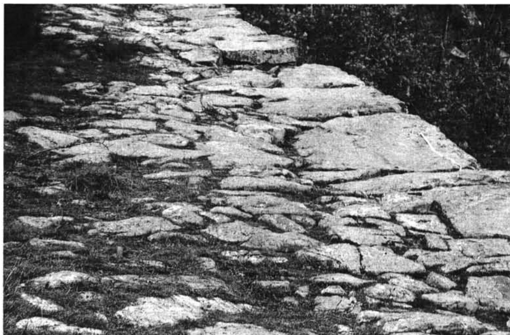
Foto 3. Detalle de las losas de la vía en el tramo de «La Vega Entrecisa». Villayandre, Crémenes
