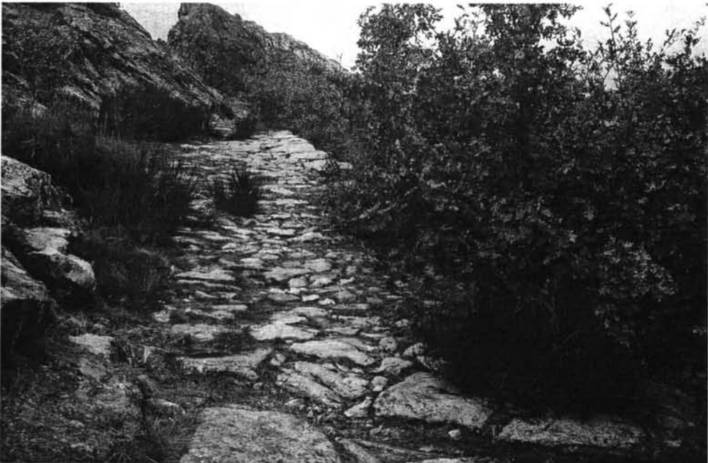
Foto 2. Vista del pavimento a la salida del corte en la roca de «La Vega entrecisa». Villayandre, Crémenes
