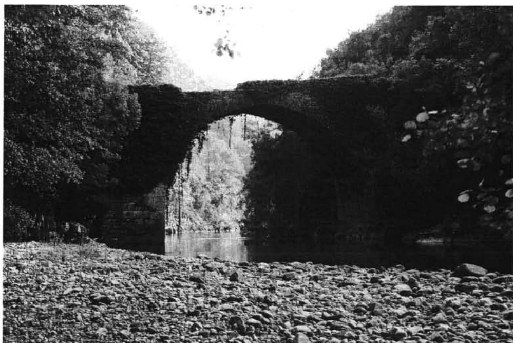
Foto 7. Vista del Puente de Los Grazos desde aguas abajo. Santillán, Amieva
