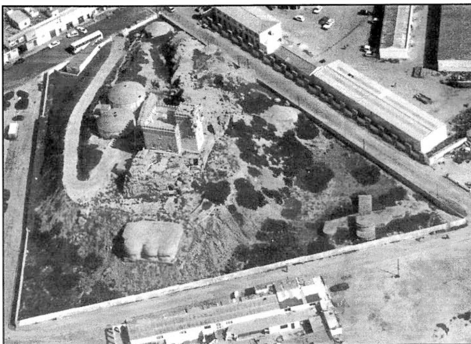
Vista aérea del recinto fortificado que ocupa actualmente el cerro y castillo de Santa Catalina. (Foto M. Rojas).
