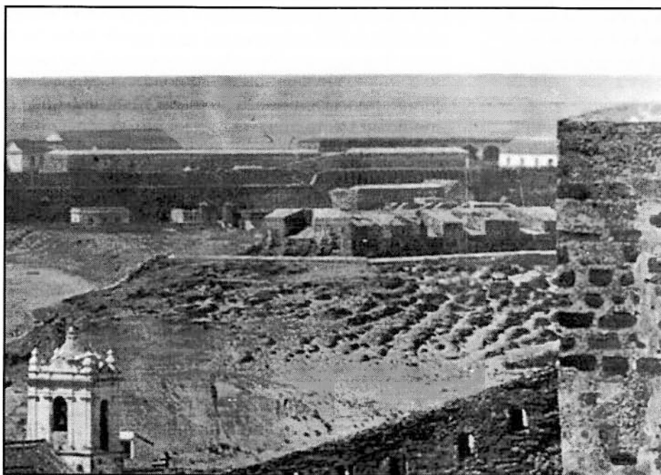
Detalle de una de las vistas que el fotógrafo francés Juan Laurent tomara de nuestra ciudad hacia 1876. En ella ya se aprecia sólo el arranque del muro aspillerado del Este que existía en prolongación de la contraescarpa.
