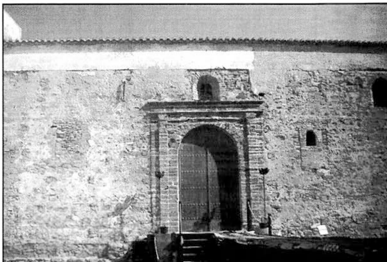
Fachada principal de la iglesia de Santa María. (Foto cedida por Wenceslao Segura).
