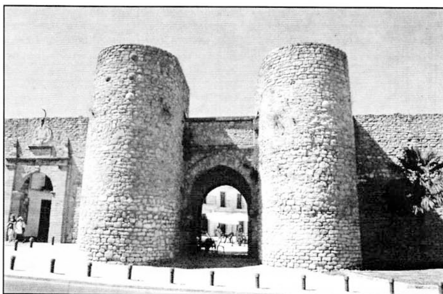
(Lám. 6). Vista general de la puerta de Almocábar en Ronda (Málaga).
