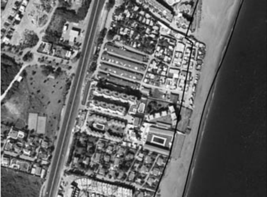
1. Transgresión del deslinde marítimo-terrestre por una urbanización en Manilva, construida con posterioridad a la entrada en vigor de la Ley de Costas. La línea negra marca la ocupación del dominio público marítimo-terrestre por las construcciones.
