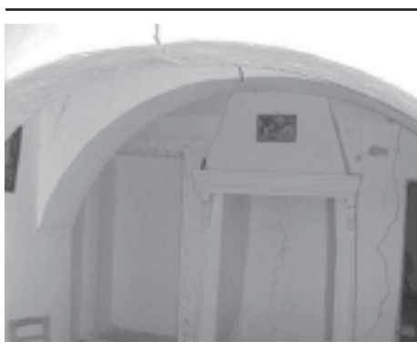
Figura n.º 16. Interior de vivienda troglodita con refuerzo de techo con arcos en Orce
