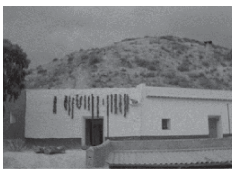
Figura n.º 15. Fachada de vivienda troglodita en La Teja (Cortes de Baza)
