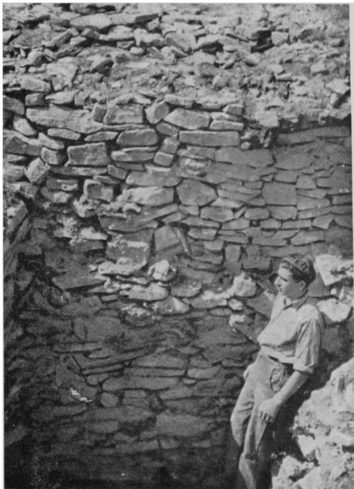
Paramento interior de la muralla
