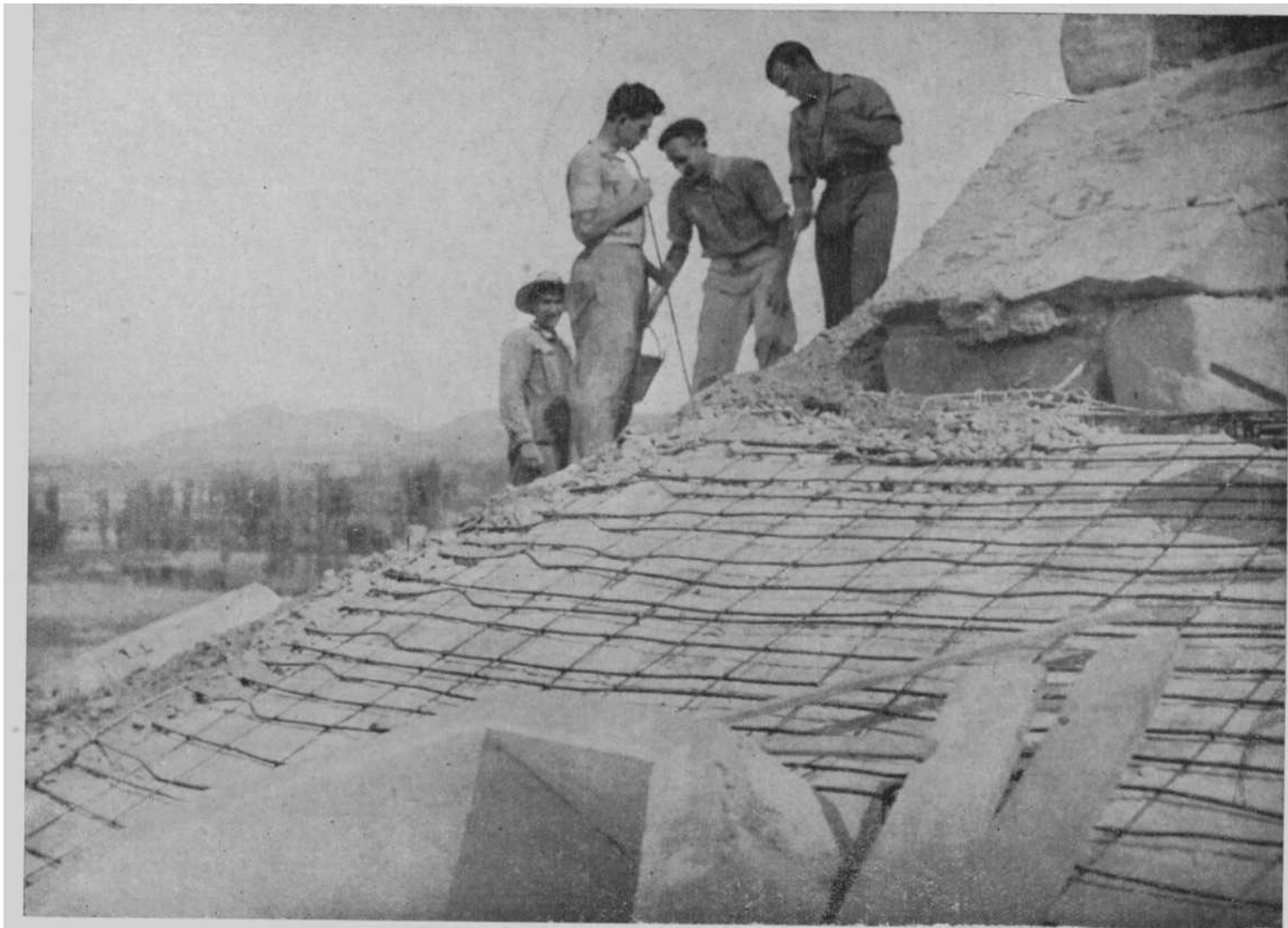
Eunate. —Obras de restauración de la cubierta
