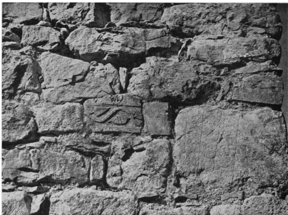
Ermita de Gastaiain: 1.—Muro norte. 2 —Muro oeste
