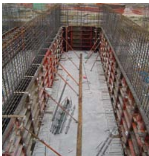
Figura 5: encofrado
