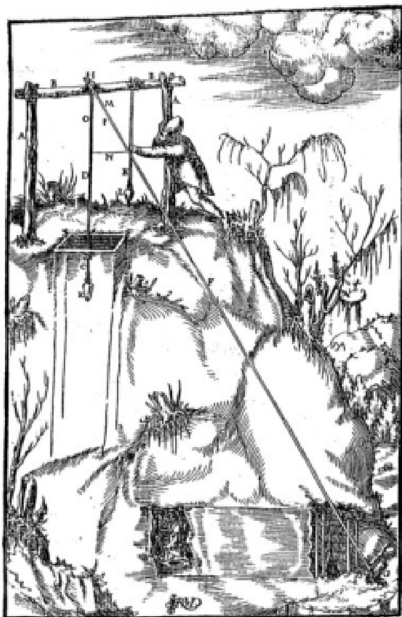
*A: postes ahuyquillados - B: viga de soporte - C: pozo - D: primera cuerda - E: plomo de la primera cuerda - F: segunda cuerda - G: extremo de ésta, fijo a tierra - H: extremo superior de la primera cuerda - I: boca del socavón - K: tercera cuerda - M: primer lado del triángulo menor - N: segundo lado del triángulo menor - O: tercer lado del triángulo menor - P: triángulo menor.*
