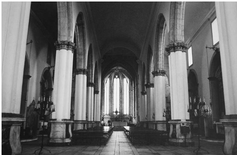
FIG. 7. Vista general del interior hacia la cabecera.
