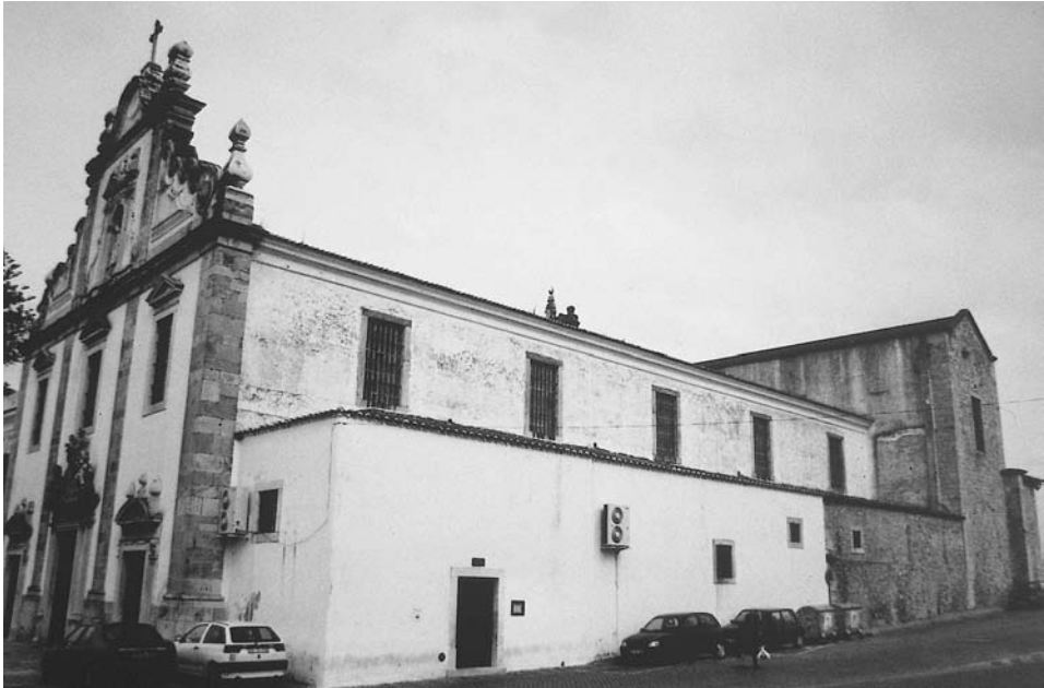
FIG. 5. Aspecto exterior del lado de la Epístola.
