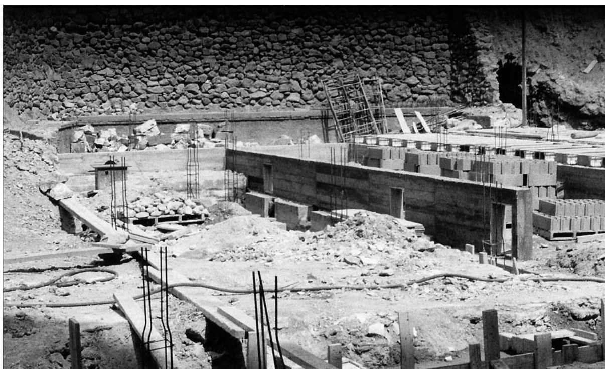
Figura 2. Al frente, pared Norte del muro de contención. A la derecha, delimitando exteriormente la abertura de la salida de agua fría, pequeño tramo de la pared Este del muro.
