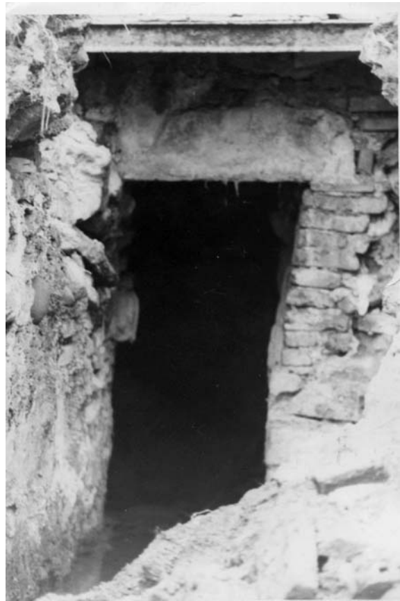
Figura 10. Galería de desagüe que parte de la arqueta.
