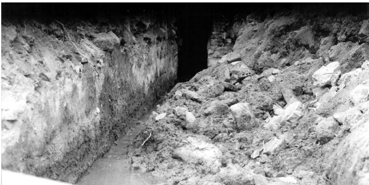
Figura 11. Vista de la galería de desagüe que parte de la arqueta.
