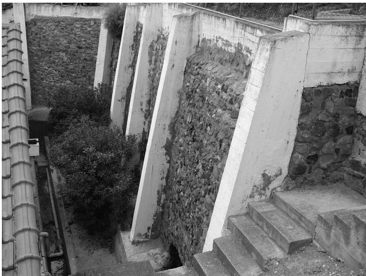
Figura 5. Muro moderno de piedras y cemento que sustituyó al muro de contención romano.
