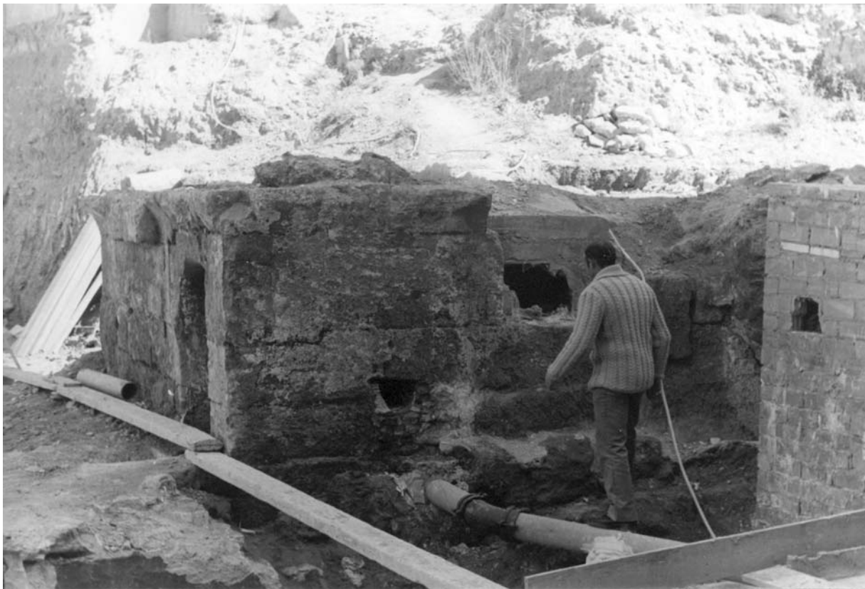
Figura 8. Fachada lateral de la arqueta durante las obras de 1982.
