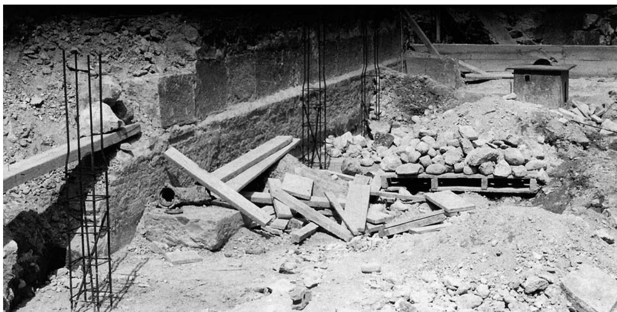
Figura 3. Cimentación y primera hilera de sillares de la pared Oeste del edificio de Lletget. Detrás de ella, piedras (parcialmente desmontadas) del muro de contención.
