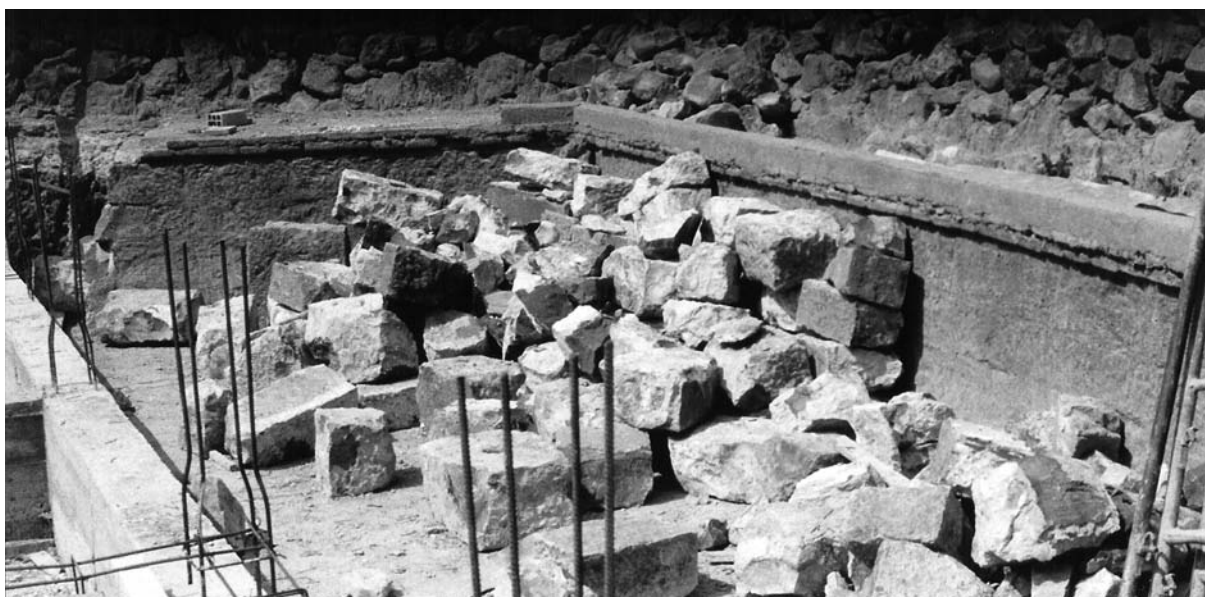
Figura 6. Esquina Noroeste del edificio de Lletget. Parcialmente desmontado, se aprecian tres hileras de sillares, cubriendo a la superior en todo el trazado visible una capa de ladrillo moderno unido con cemento. Detrás, piedras del muro de contención.
