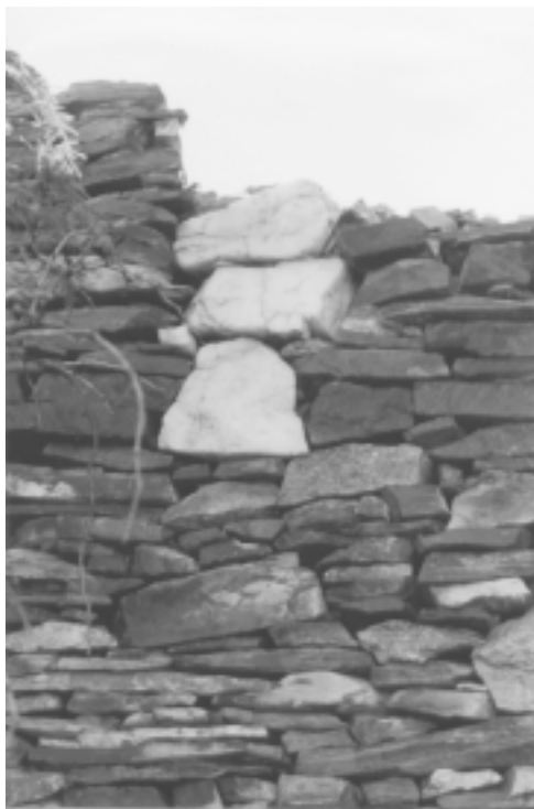
Figura 7. Muro decorado del recinto 57
